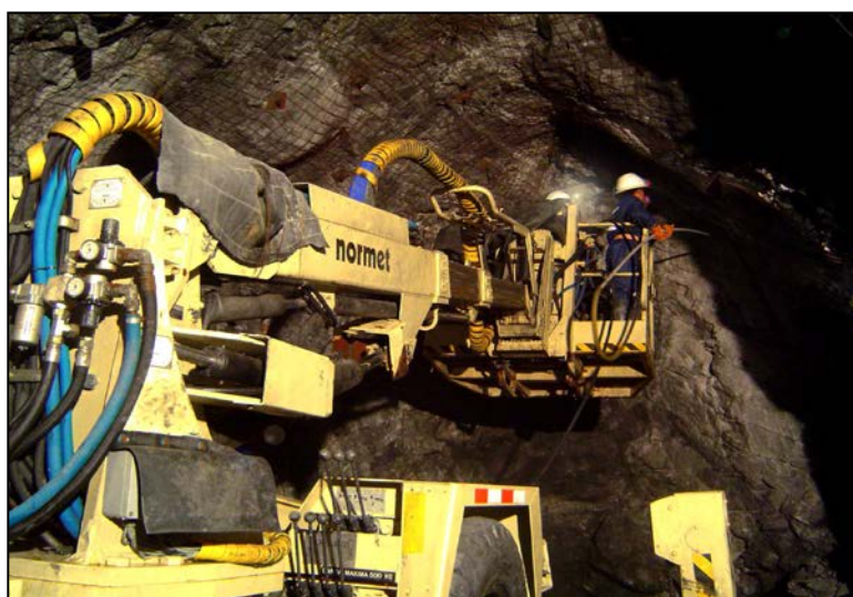
Figura N° 2.12: Anfoloader en Operación en interior mina
