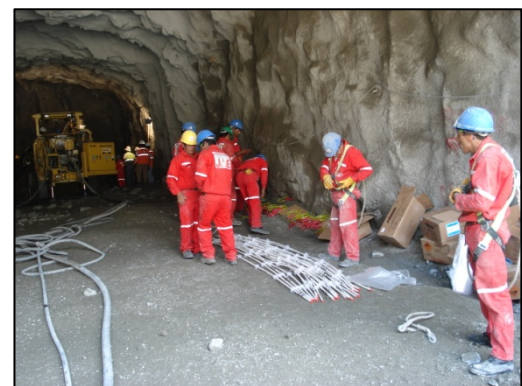
Perforación del frente y preparación de Famecorte para
