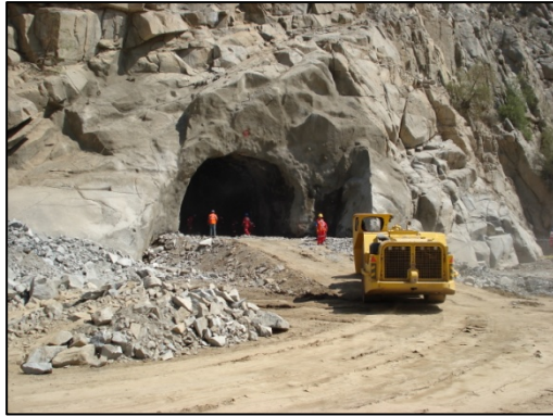
Inicio de construcción de Túnel de Acceso a medio banco
