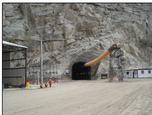
Sistema de ventilación y Perforación del Túnel de avance a sección completa
