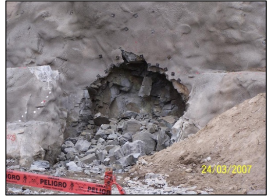
Inicio de la excavación del Túnel de Descarga
