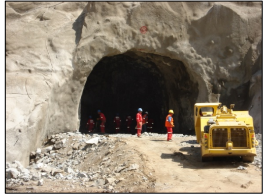
Inicio de construcción de Túnel de Acceso a medio banco
