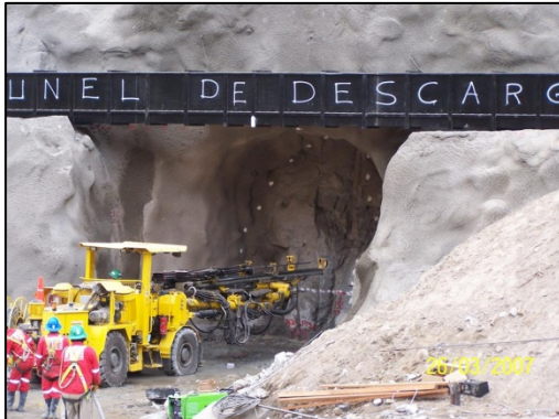
Avance de la excavación del Túnel de Descarga
