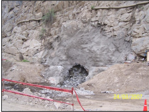
Inicio de la excavación del Túnel de Descarga
