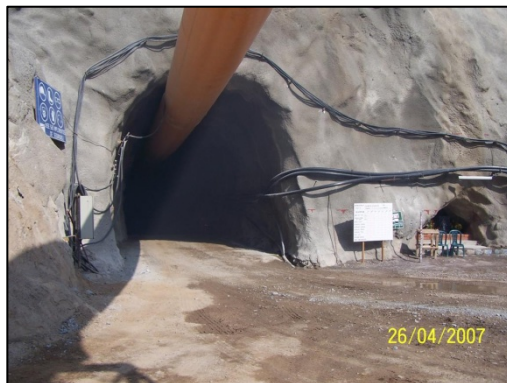
Excavación del Túnel Intermedio con sistema de ventilación forzada
