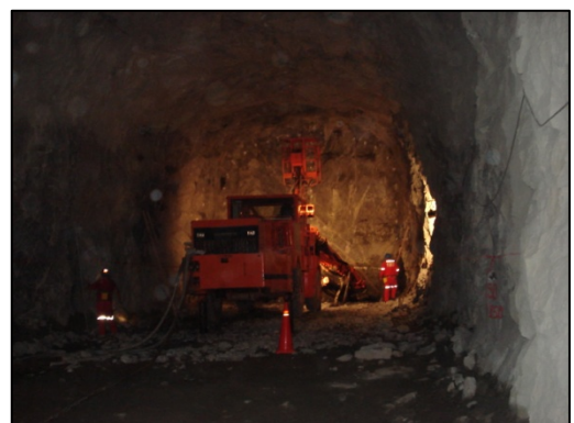
Sistema de ventilación y Perforación del Túnel de avance a sección completa
