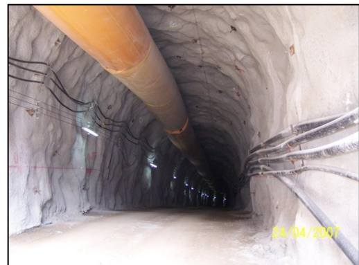
Excavación del Túnel Intermedio con sistema de ventilación forzada
