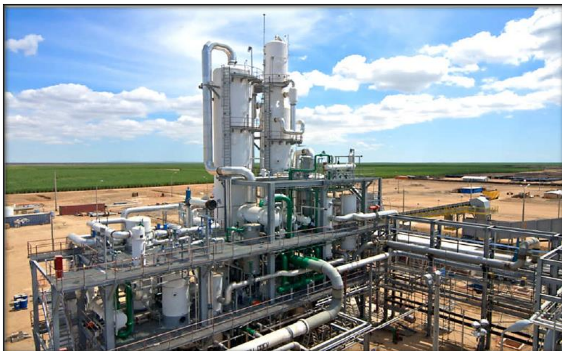
Foto.2.6 Etapa de destilación (Cortesía Maple Etanol S.R.L).
