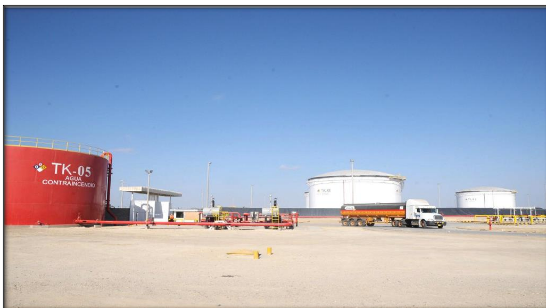
Foto.2.8 Instalaciones de despacho (Cortesía Maple Etanol S.R.L).
