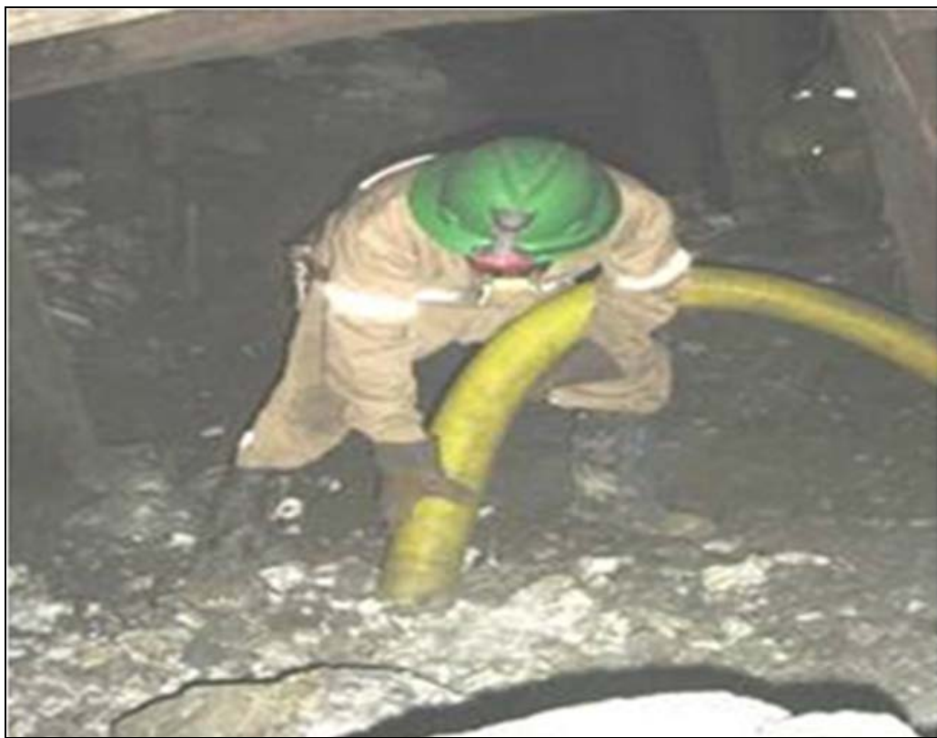
Foto N° 1, Maquina Trans Vac en proceso de recuperación de finos
