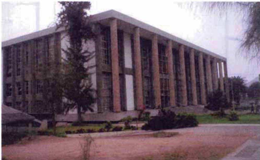
Figura N° 2.2.- Vista de la estructura estudiada.
