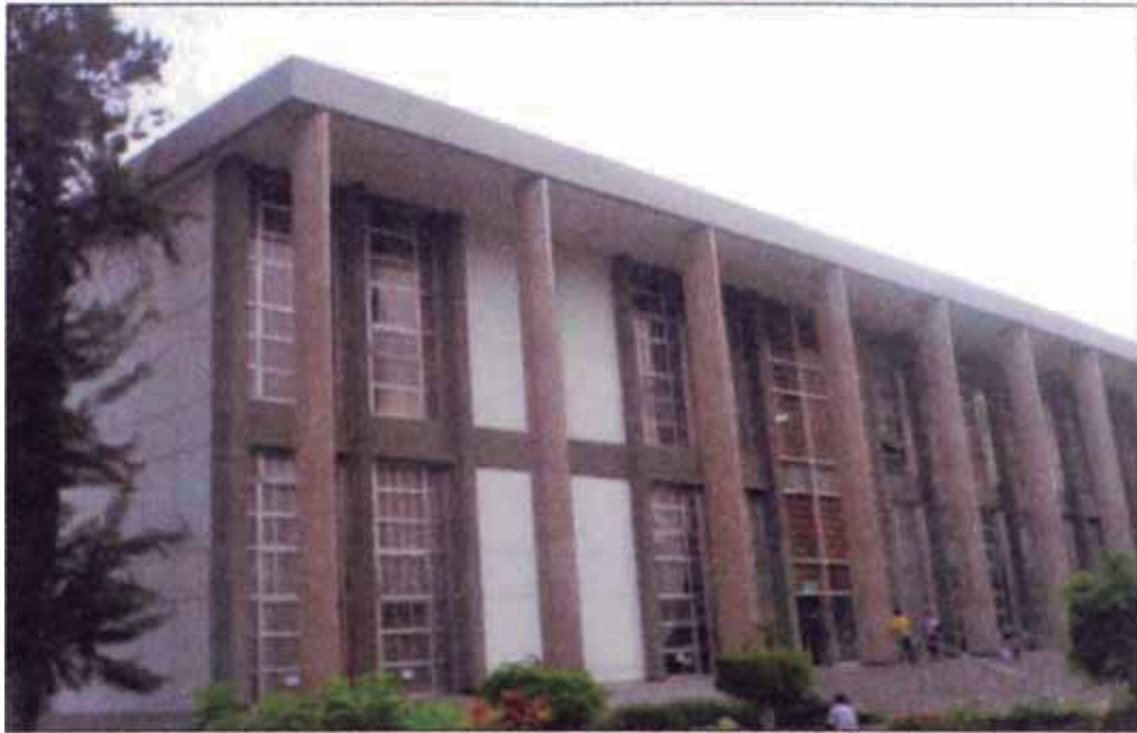
Figura N° 2.15.- Vista frontal de la Biblioteca (doble altura).
