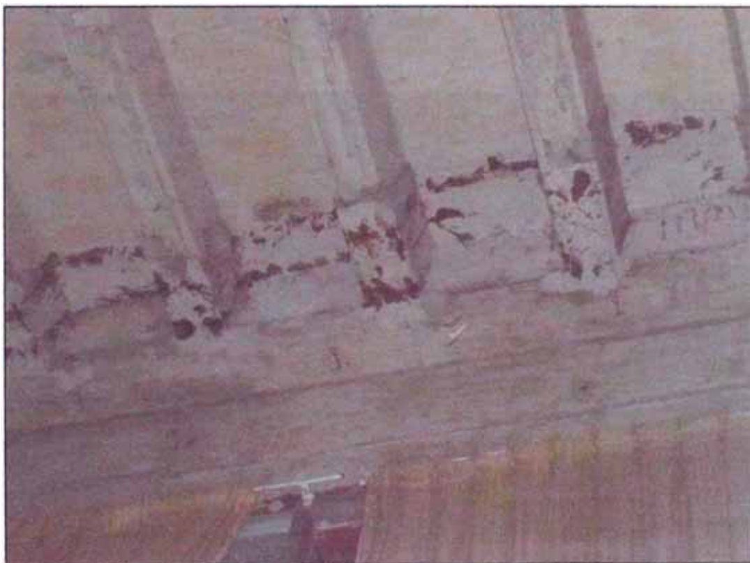
Figura N° 2.18.- Vista de lado lateral transversal – Reparación de la losa nervada.
