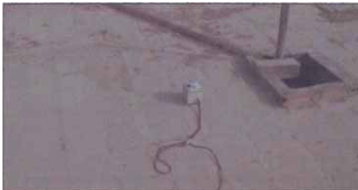
Figura N° 3.1.- Vista del sensor ubicado en el centro geométrico de la azotea (equipo del CISMID).
