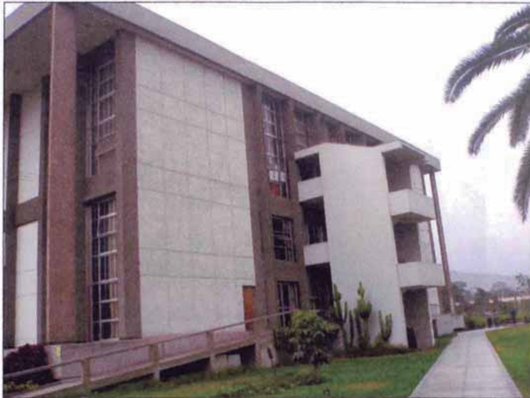
Figura N° 2.17.- Vista lado lateral transversal de la Biblioteca (lado Oeste).
