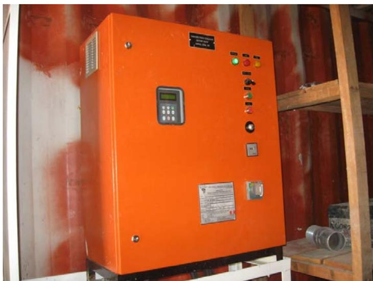
Fig. 4.20.-Tablero con variador de velocidad
