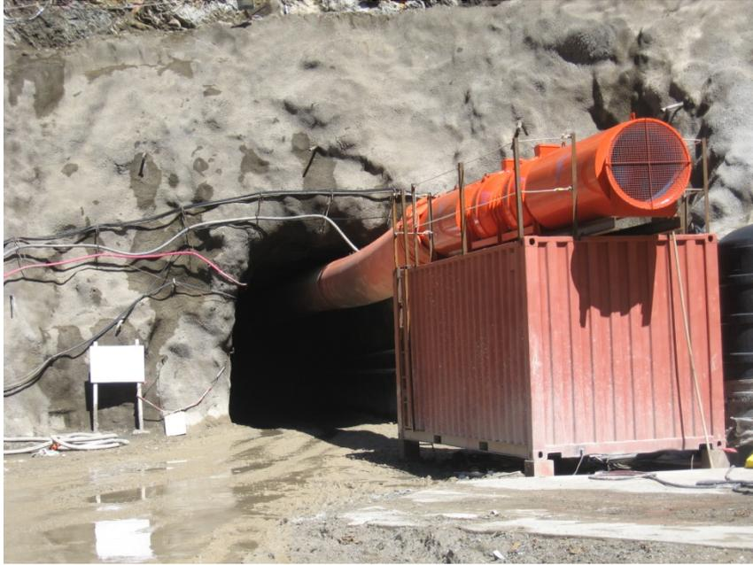
Fig.1.11-Dos ventiladores en serie sobre un container
