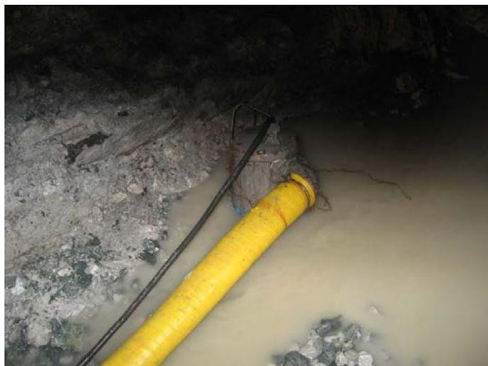
Fig.1.17.- Bomba sumergible
