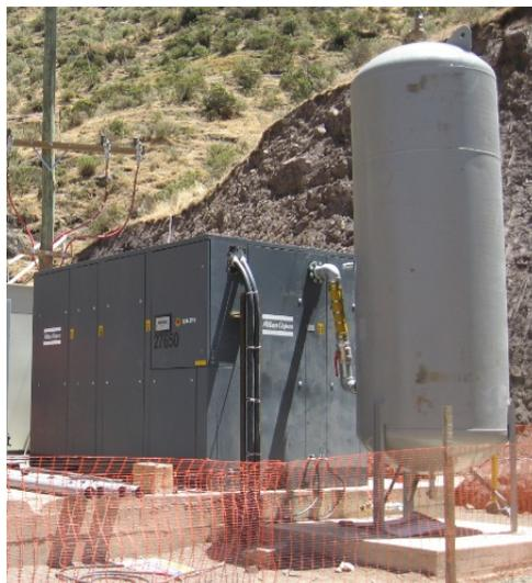
Fig. 4.9.-Tanque para el aire comprimido
