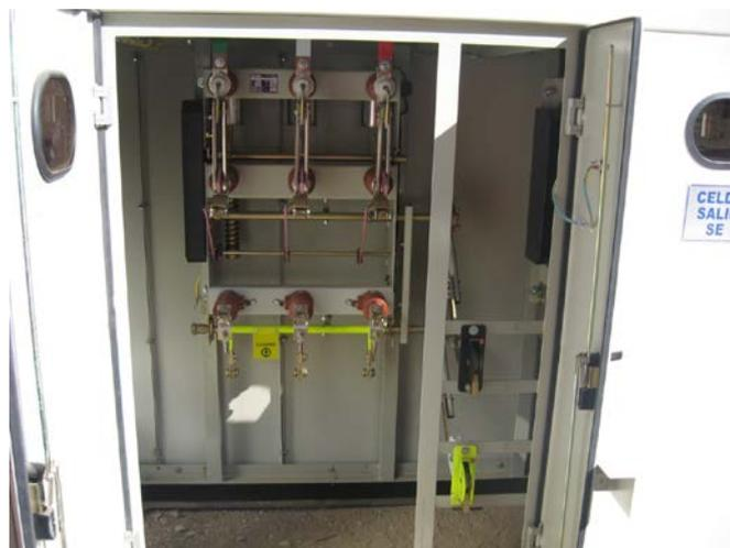
Fig.3.24.- Celda de derivación
