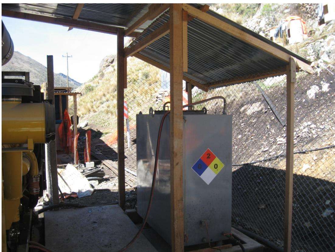
Fig.1.20.-Tanque de combustible para grupo electrónico
