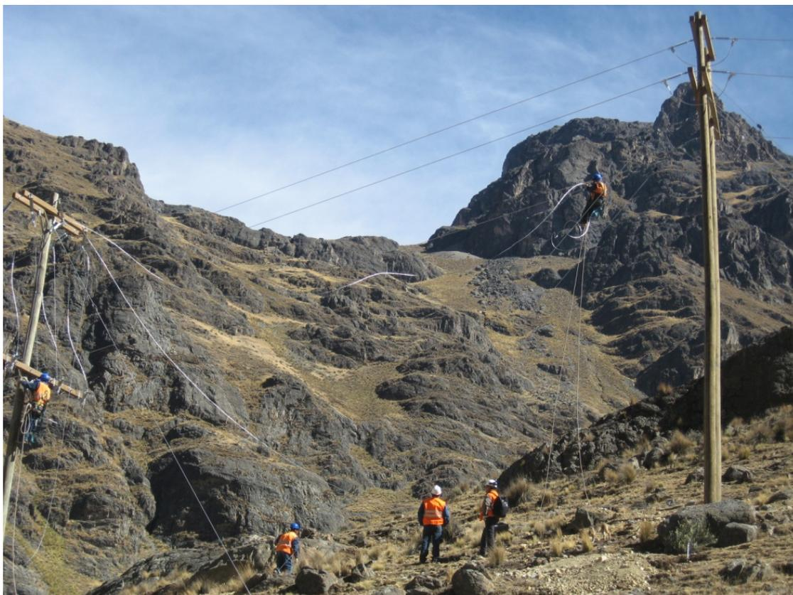
Fig.1.21.- Tendido de red de media tensión
