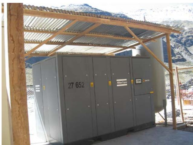
Fig.1.10-Compresora con su respectivo tanque
