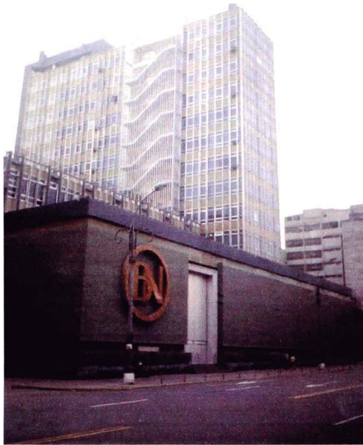
Estado original del edificio
