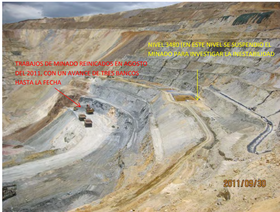
Fotografía 13.2 Estado actual del talud Norte, luego de la implementación de los 5 pozos de drenaje se ha podido reiniciar los trabajos de minado.
