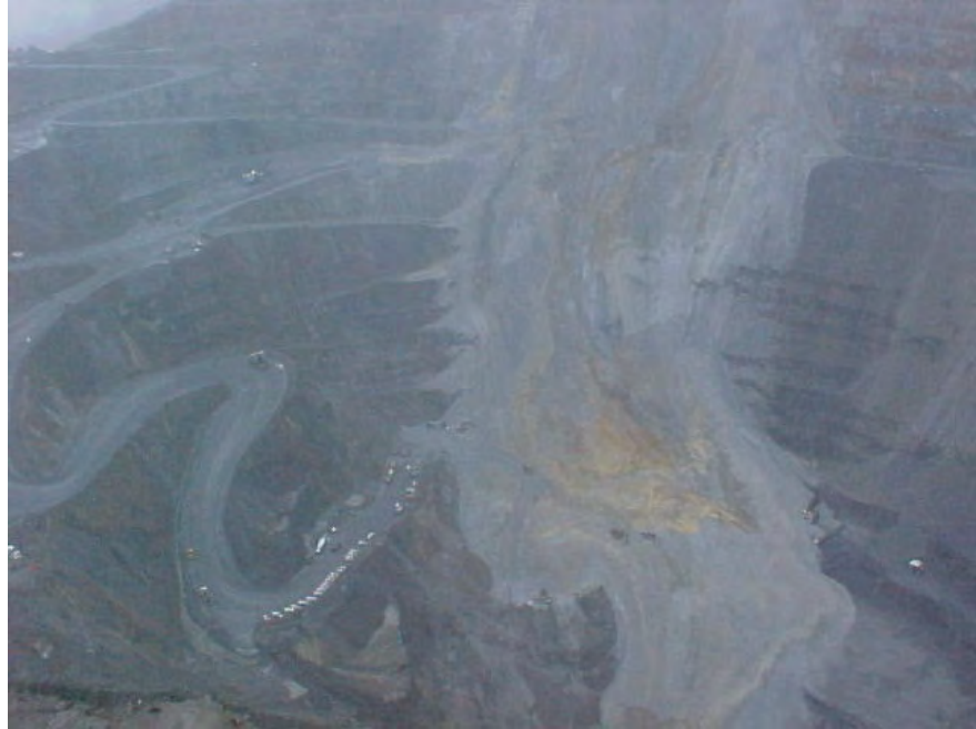
Fotografía 1.1 Falla de talud del tipo flujo, en la mina de cobre “Grasberg” de Indonesia.
