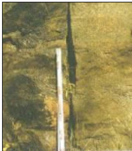
Foto 4: Discontinuidad con apertura en areniscas
