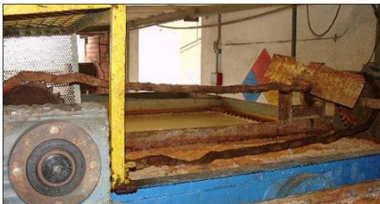
Figura N°4.7: Sedimentador lamelar para separación de residuos poliméricos
