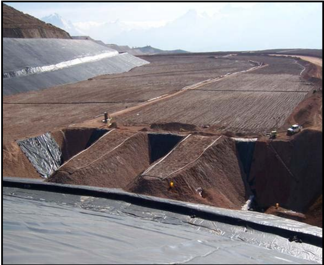
Vista general de las pilas de mineral
