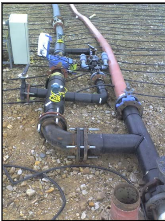
Figura N o 4.3 Usando tuberías tipo T
