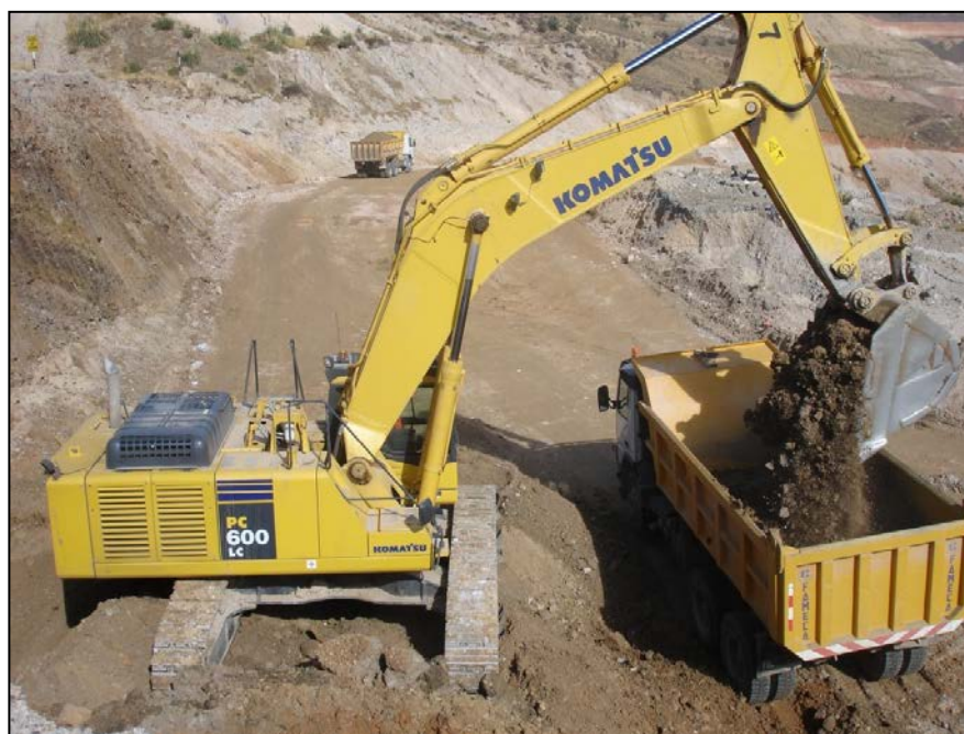
Ilustración 10.1 Carguío de desmote con excavadora PC600 Komatsu
