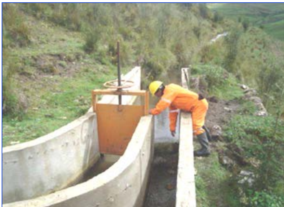
Ilustración 8 Mantenimiento de canal.
