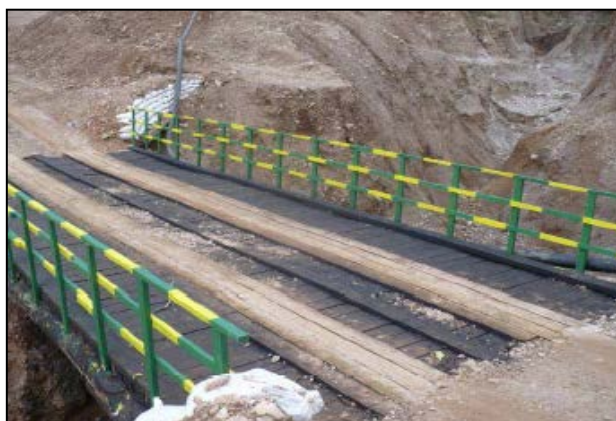
Ilustración 8.2 Construcción de puentes.
