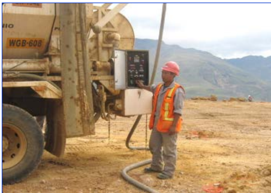
Ilustración 4.6 Pantalla PLC camión fábrica.
