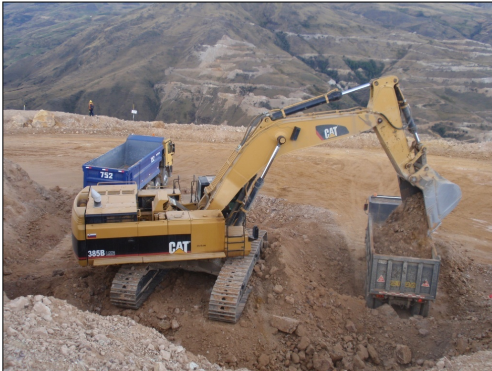
Ilustración 10.2 Carguío de desmonte con excavadora 385BL Caterpillar
