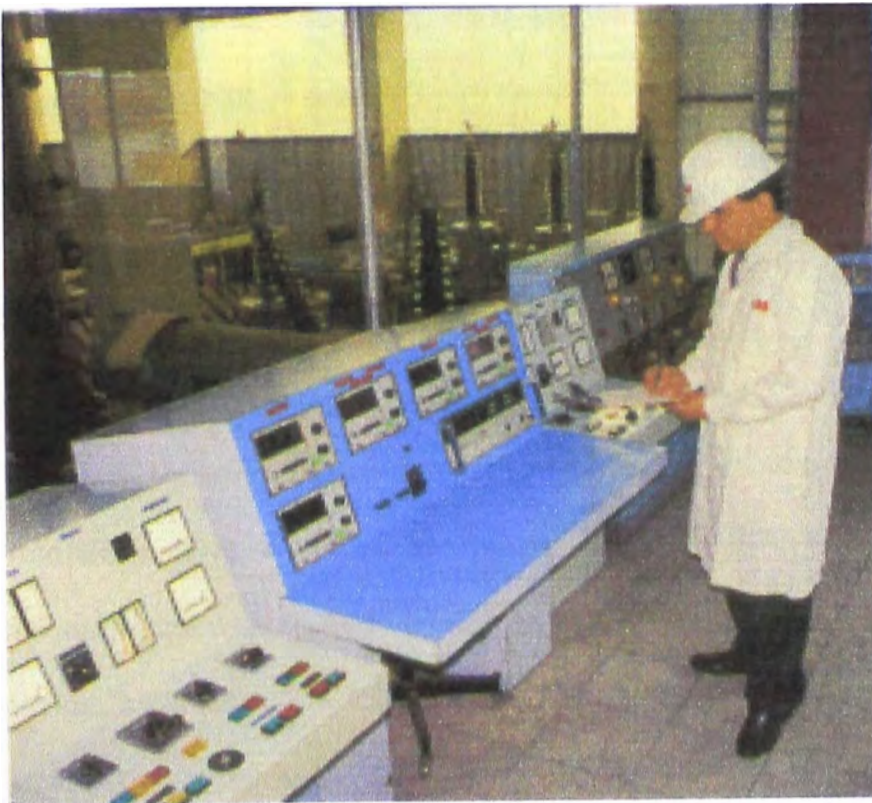
Fig. 3-1. Vista parcial de la Sala de Pruebas
