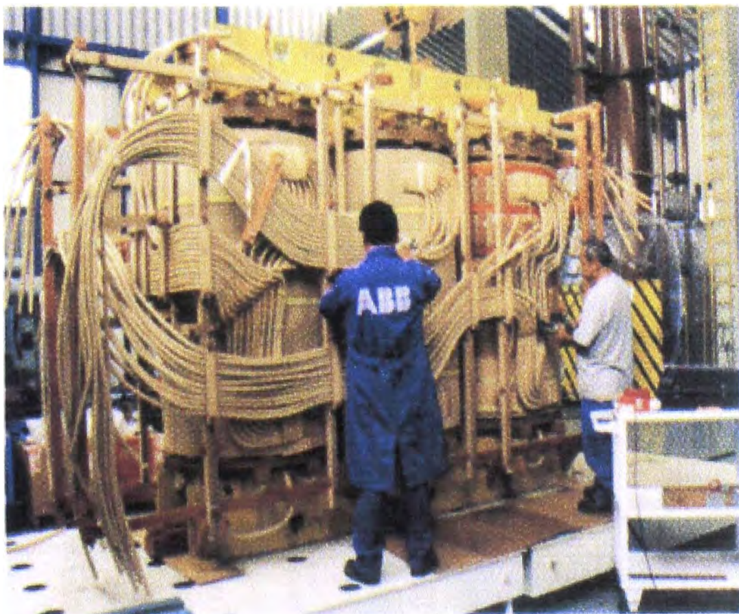
Fig. 2-11 Control y Armado del bobinado Transformador de Potencia.
