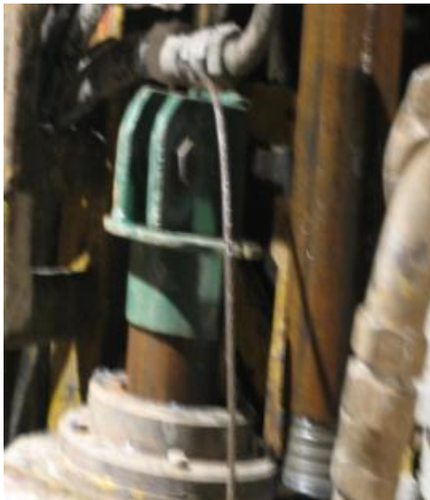
Foto 17: Grampa Mecánica asegurando Cable Wire Line
