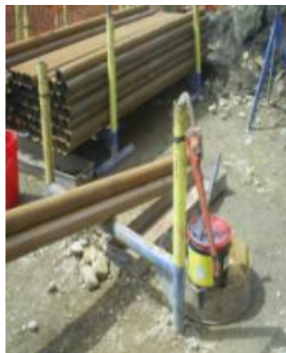
Foto 28: Colgador tipo S para colgar Tubería
