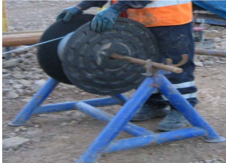
Foto 23: Personal instalando Cable Wire Line con el Caballete
