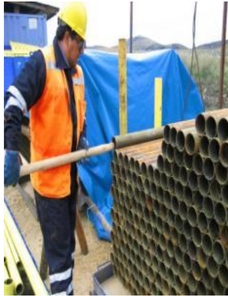
Foto 19: Personal manipulando Tubería Civiles
