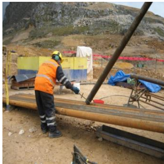
Foto 21: Personal manipulando Tubería con Ganchos de Fierro
