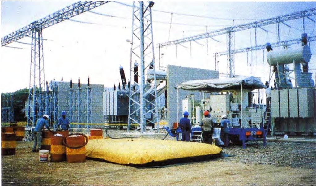
8.1 Llenado de aceite de los cilindros hacia la bolsa contenedora mediante la planta de termo-vacío
