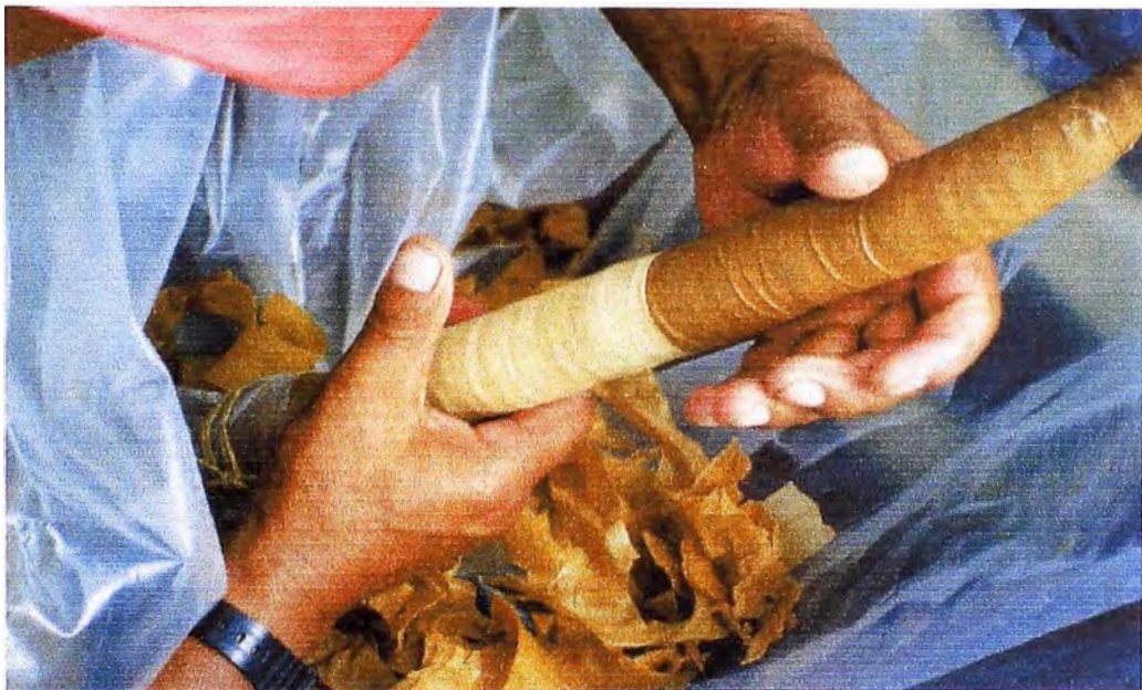
5.4 Cable de acometida con aislamiento de papel reparado
