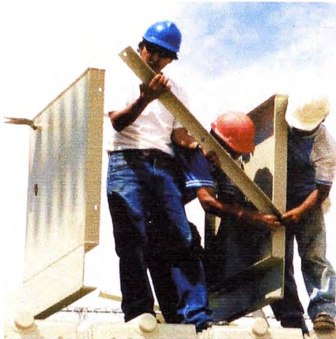
2.1 Montaje de estructura soporte del tanque de expansión
