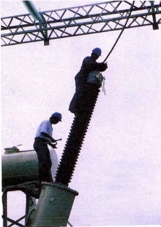
13.1 Conexionado bornas AT
