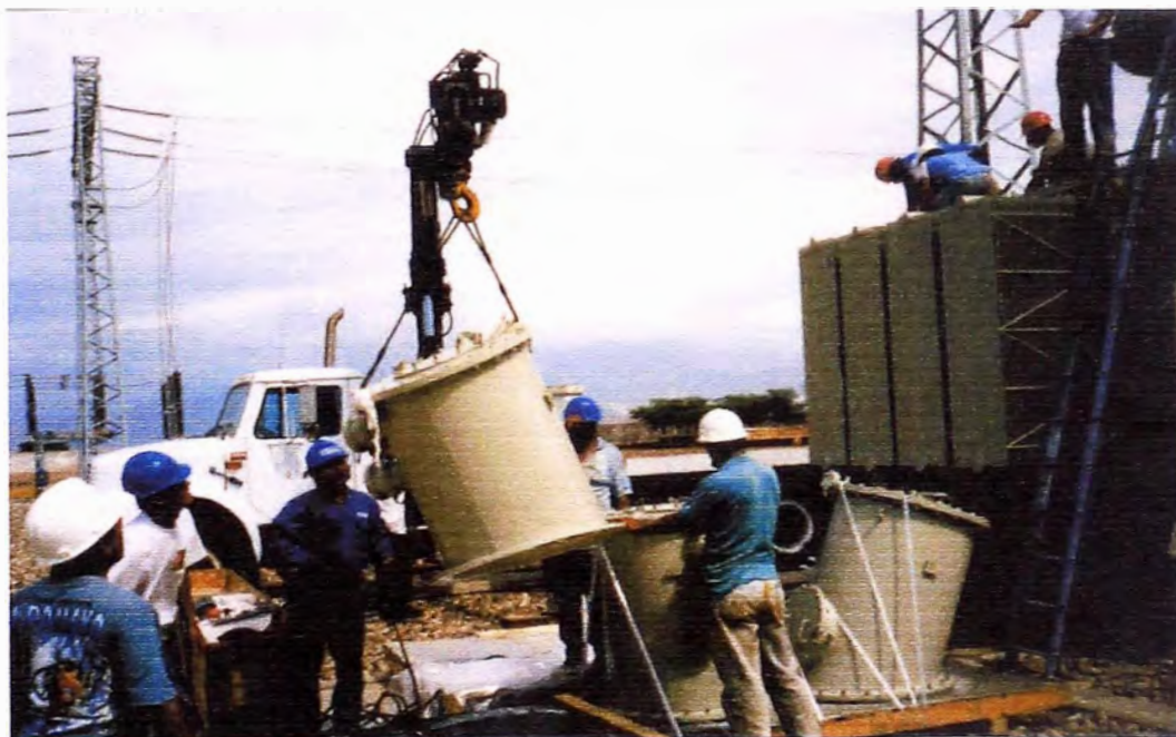
3.2 Izamiento de los transformadores de corriente toroidales
