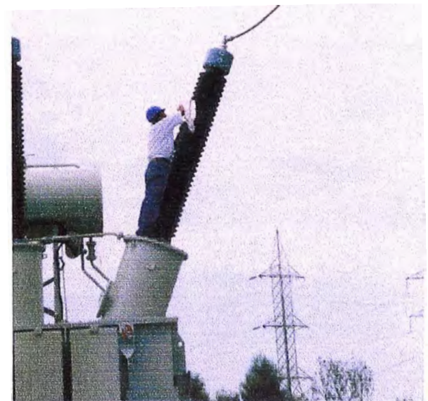
13.2 Limpieza del aislamiento de los bushing
