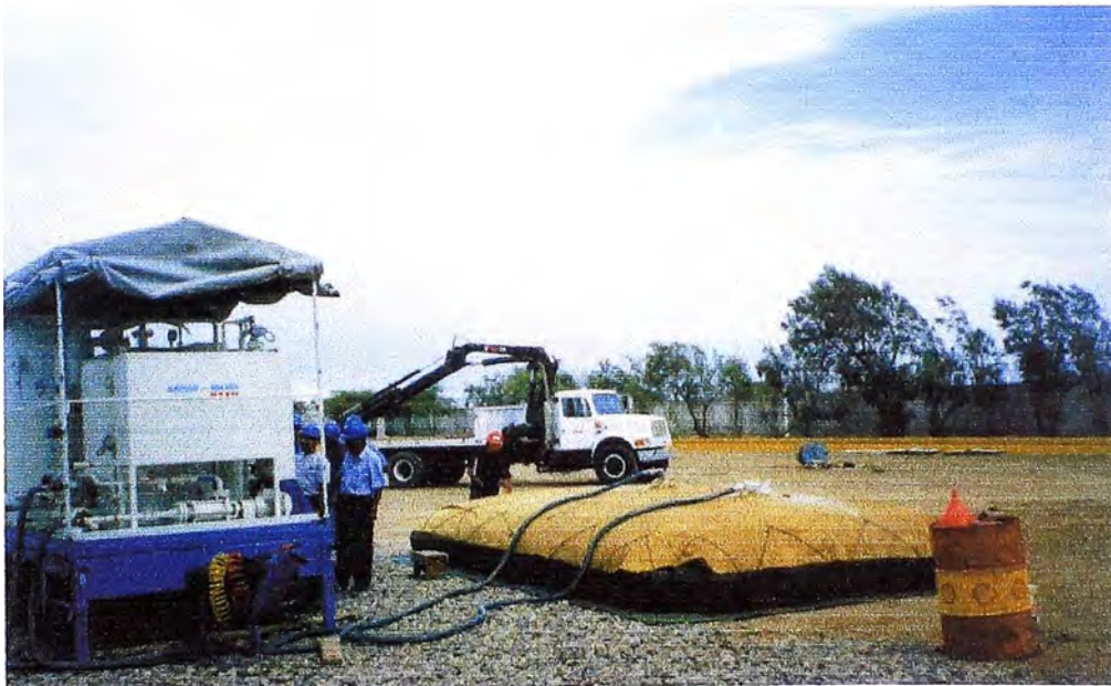
8.2 Tratamiento del aceite de la bolsa contenedora por termo-vacío
