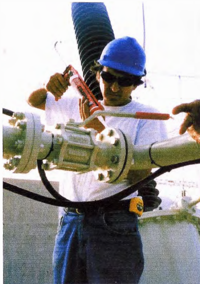
6.2 Aplicación de silicona para protección del empaque
