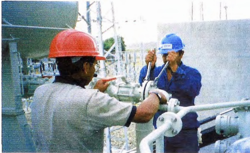
6.1 Montaje de relé Buchholz
