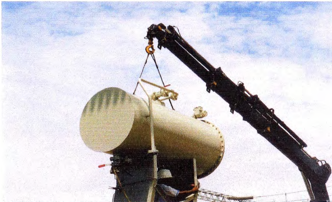
2.2 Montaje del tanque de expansión
