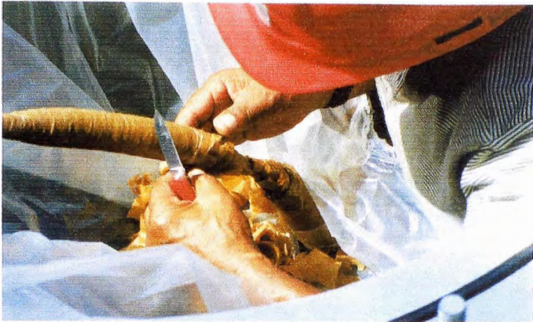
5.3 Retiro de papel crepe dañado para aplicar una nueva capa de aislamiento
