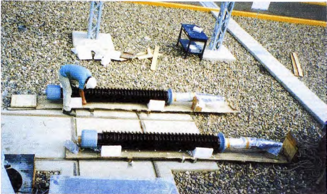
4.1 Limpieza e inspección de los bushings 220 kV
