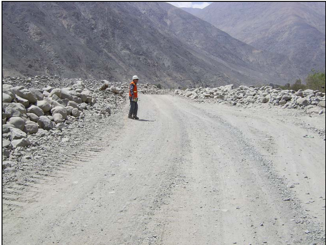
Fotografía No. 3.- Acceso hacia el área de la Planta de Beneficio de Laytaruma. Carretera afirmada
