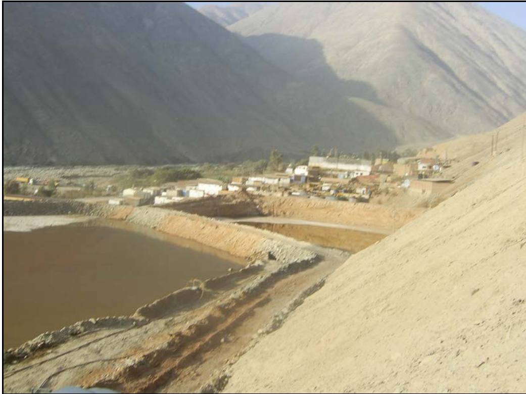
Fotografía No. 7.- Relavera actual colindante a la Planta de Beneficio que se observa al fondo en la quebrada Acaville
