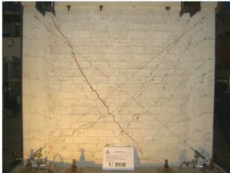
Foto 2: Agrietamientos producidos para la distorsión angular de 1/200
