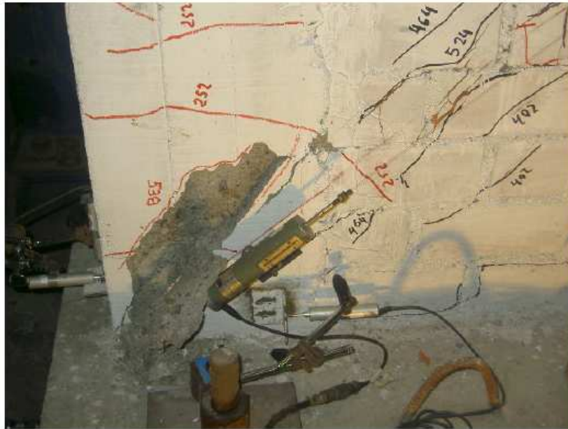
Foto 3: Detalle de agrietamientos y de la posición del sensor
