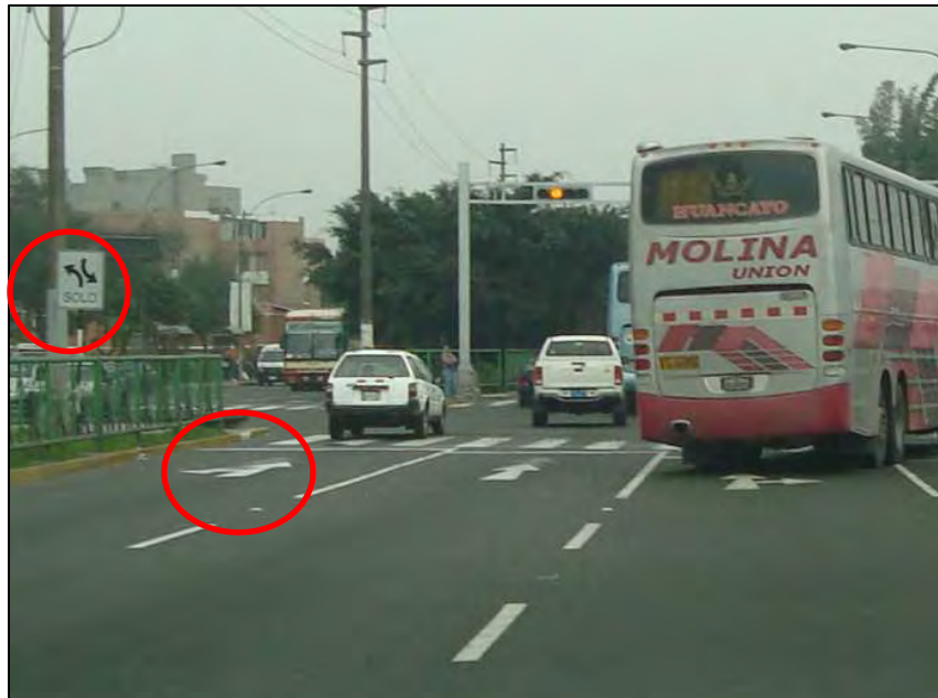
Fig. 3.02.18. La intersección usa la señal de solo giro, sin embargo el carril izquierdo de la calzada muestra que ese carril no solo es para giro sino también para seguir de frente.
