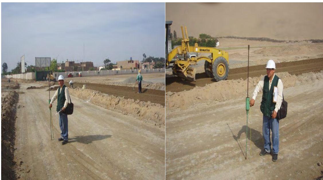
Figura 4.1: Ensayos con PDC en conformación de subrasante en Santa María
