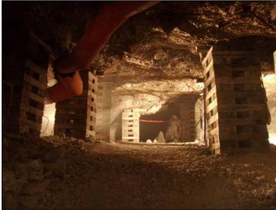
Figura 19: Sostenimiento con Paquetes de madera
