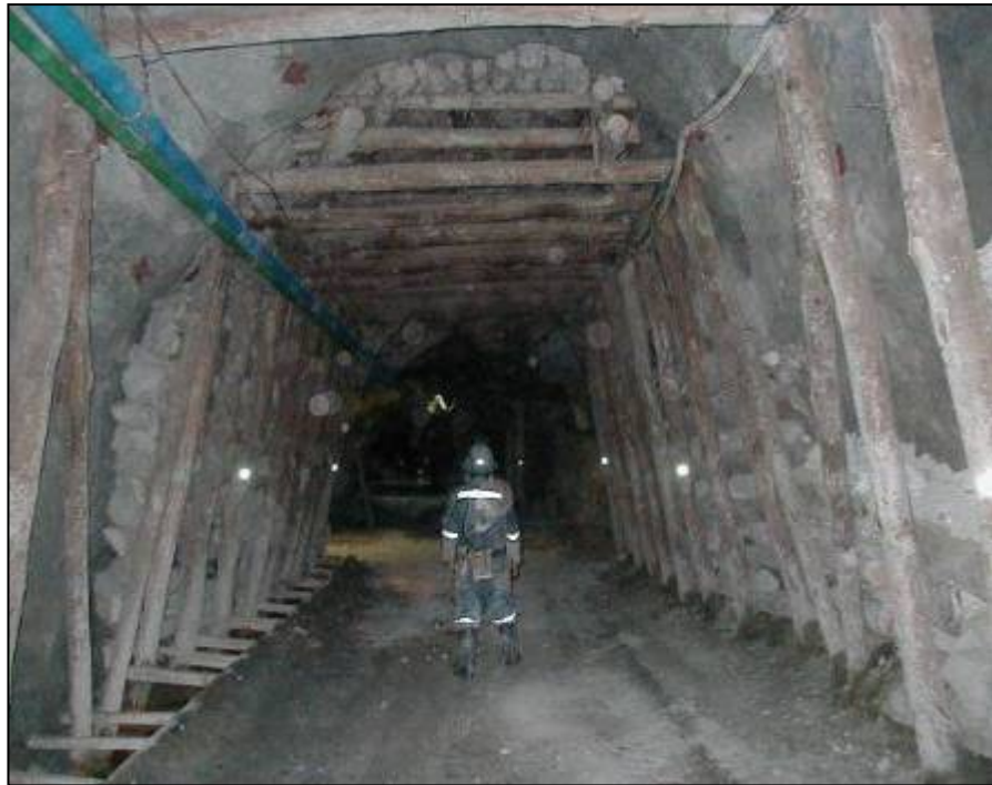
Figura 20: Sostenimiento con cuadros de madera
