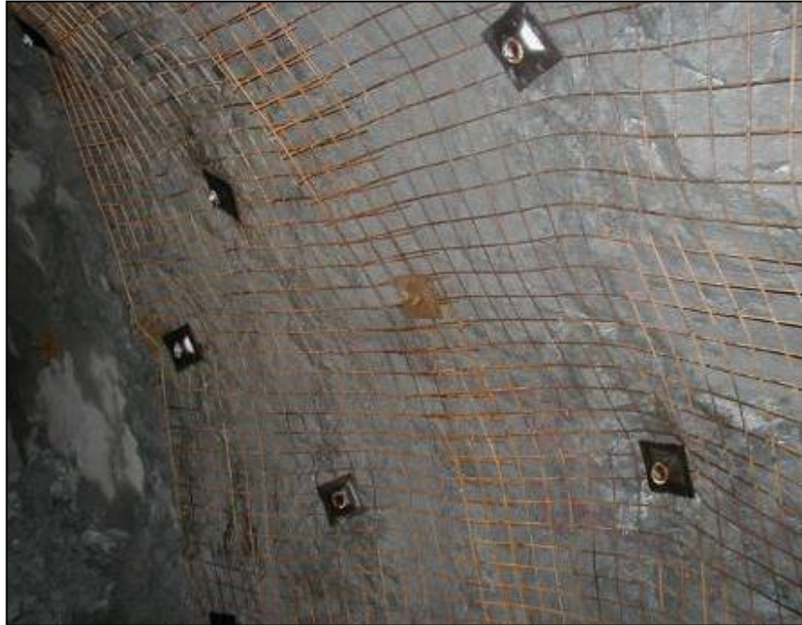
Figura 21: Sostenimiento con malla metálica (electrosoldada)
