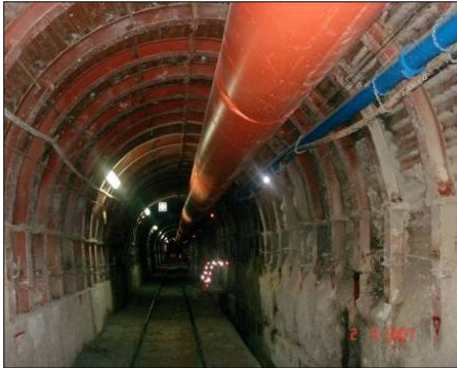
Figura 22: Sostenimiento con Cimbras metálicas
