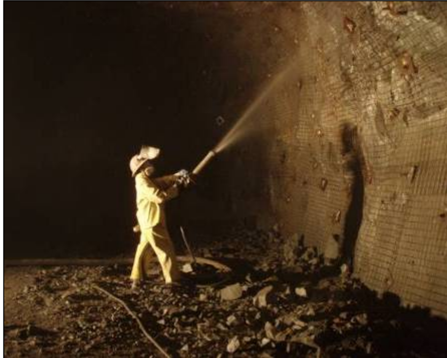
Figura 23: Sostenimiento con Concreto lanzado (Shotcrete)
