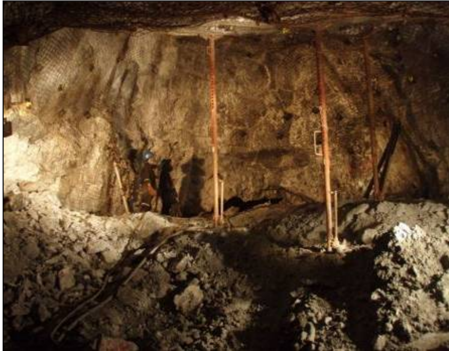
Figura 18: Sostenimiento con Gatas Mecánicas
