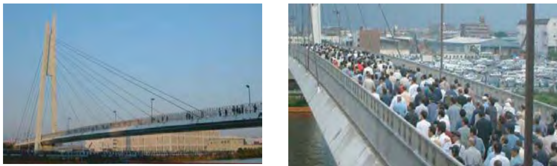
Figura 2.3. Puente peatonal Toda Park en la ciudad de Toda, Japón. (Thór, 2011)
