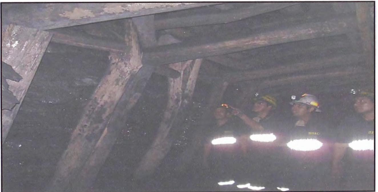
FOTO N° 05.- Sostenimiento con puntales de eucalipto d 8-10 pulgadas de diámetro.
