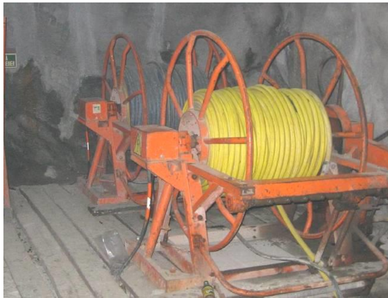
Ilustración 16 Carretes de cable eléctrico
