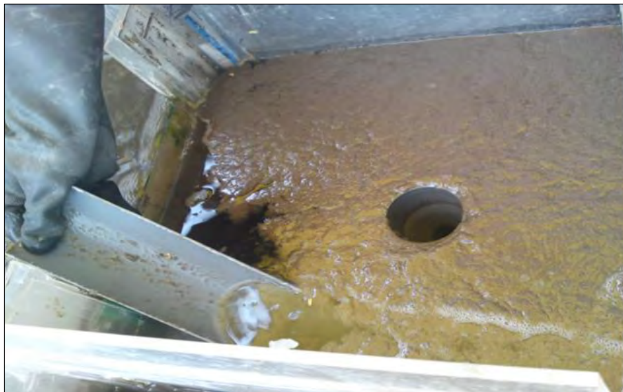
Figura 59. Levantamiento del lodo en el sedimentador secundario.
