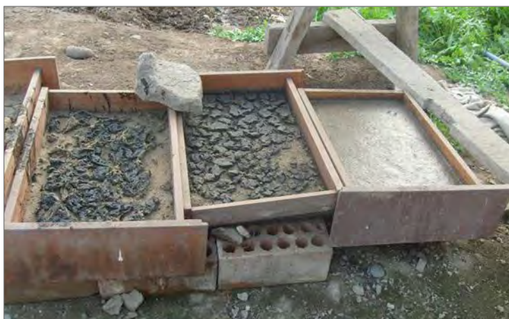
Figura 47. Lecho de secado del Reactor R1.
