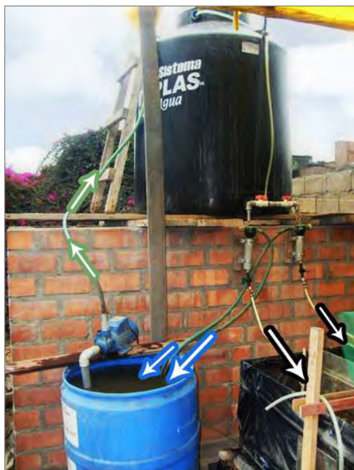
Figura 23. Recirculación del rebose al tanque de homogenización.
