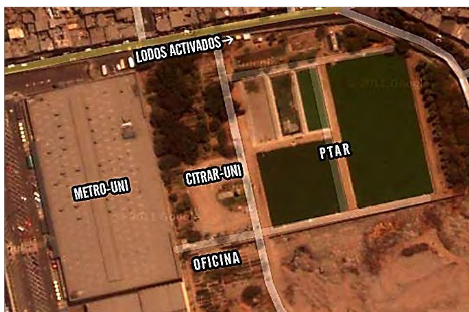
Figura 7. Ubicación del Sistema de Lodos Activados en las instalaciones de CITRAR-UNI.
