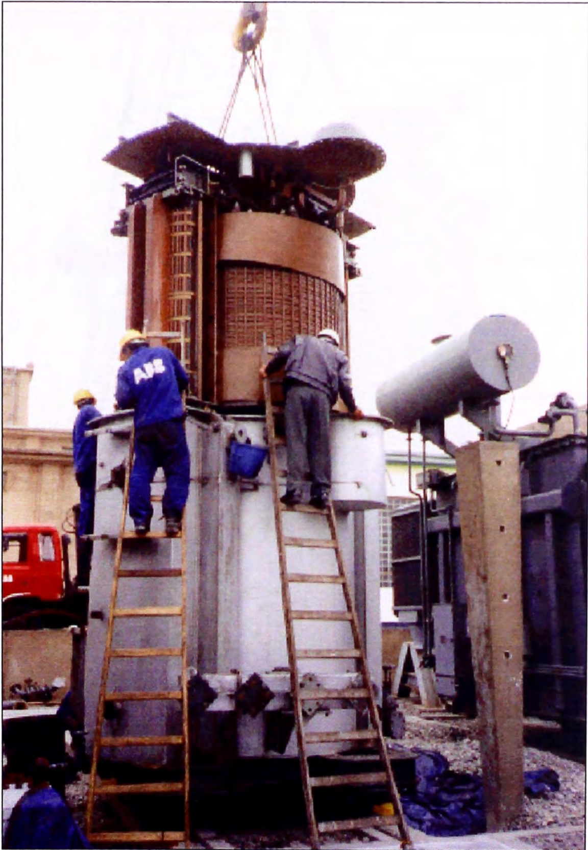
Foto 3: Introducción de la Parte Activa del Transformador a la cuba
