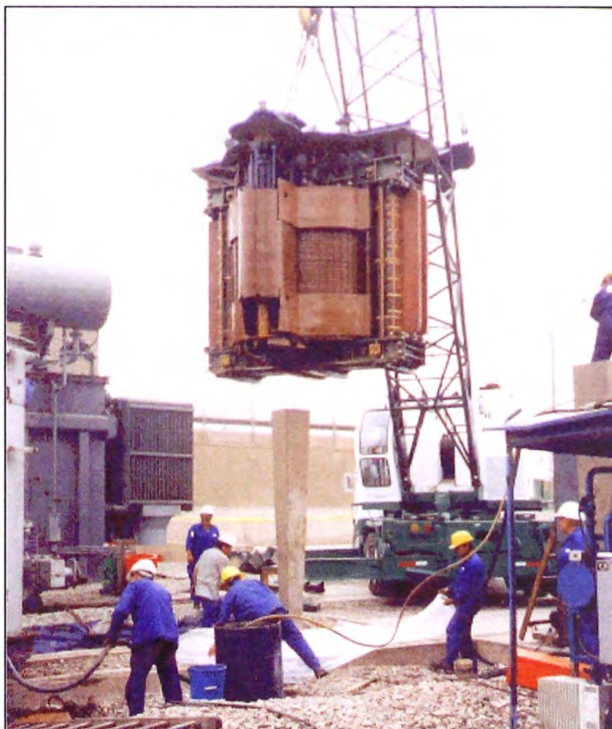
Foto 2: Levantamiento del Transformador
