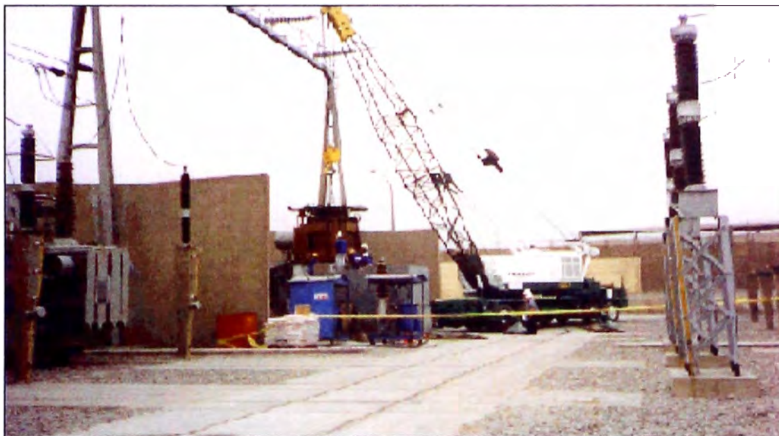
Foto 1: Izaje del Transformador
