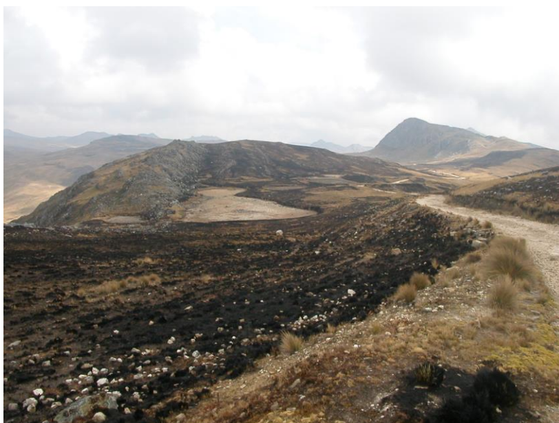
Figura III.12 Camino de Acceso a la Mina
