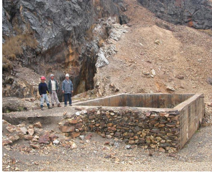
Figura III.7 Poza de Almacenamiento de agua
