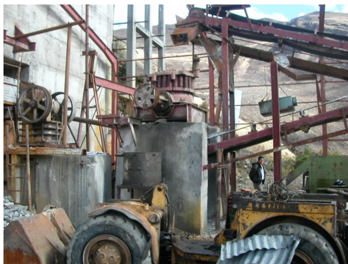
Figura III.4 Zona de Chancado
