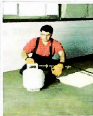
3.- Control de fugas
