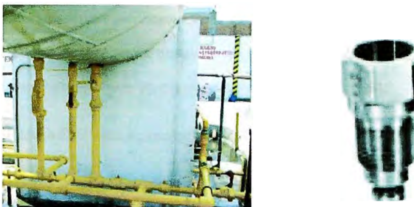
Figura 7-3 Válvulas de exceso de flujo
