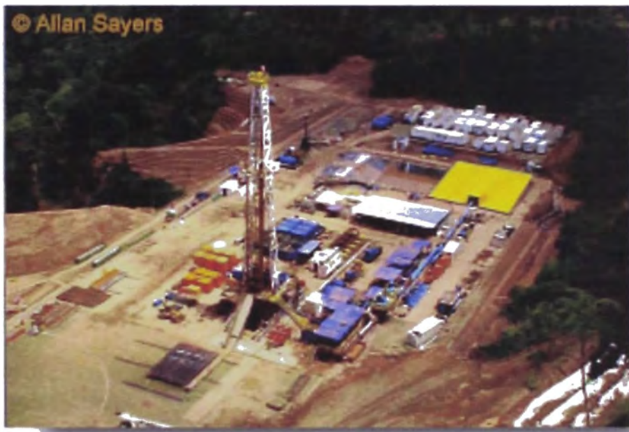
Vista del emplazamiento del pozo Cashiriari 3
