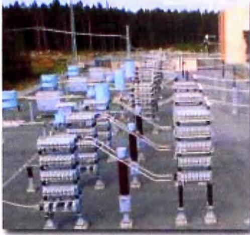
**Figura 3.12** Filtros de CA de 400Kv tipo capacitor shunt en transmisión HVDC
