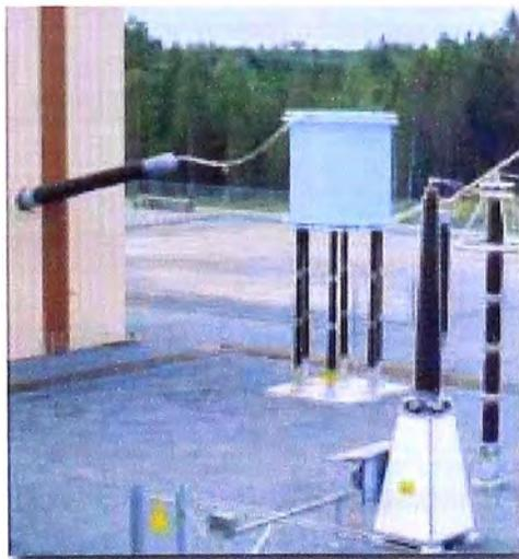
**Figura 3.9** Reactor de alisamiento de corazón de aire en transmisión HVDC
