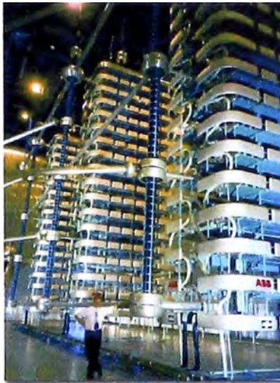
**Figura 5.6.-** Válvulas del Convertidor en la sala de la estación de Chandrapur-Padghe
