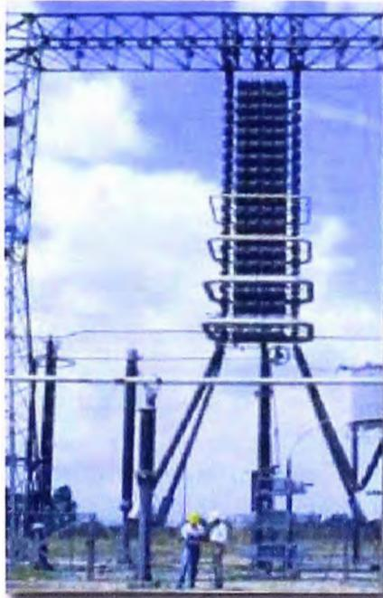
**Figura 3.13** Filtro de CC de 500Kv con capacitores suspendidos en transmisión HVDC
