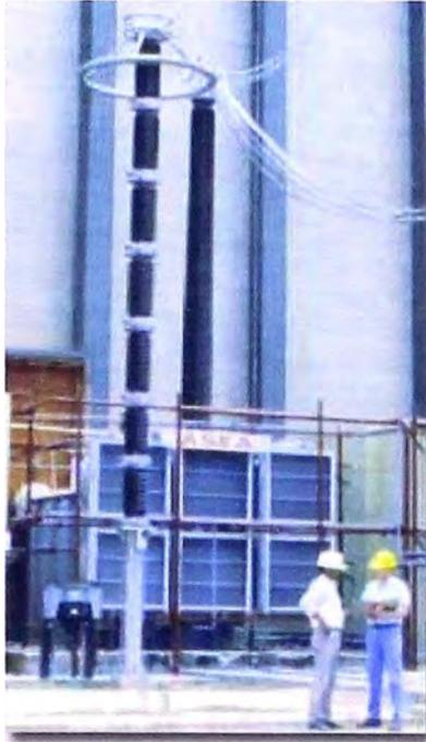
**Figura 3.10** Reactor de alisamiento enfriado en aceite en transmisión HVDC
