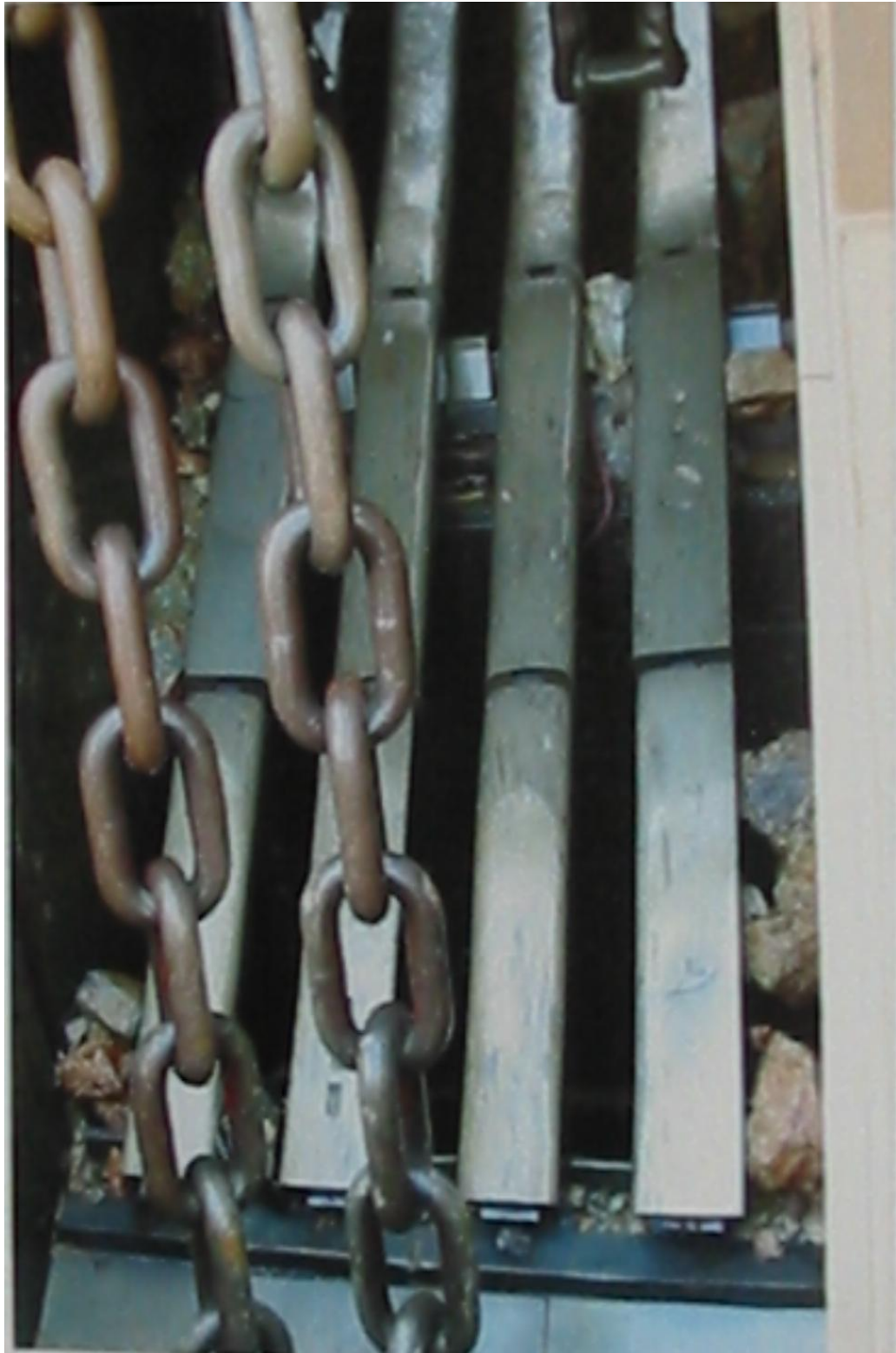
Ilustración 20. Grizzlys modificados después de 2 meses de la ejecución del proyecto
