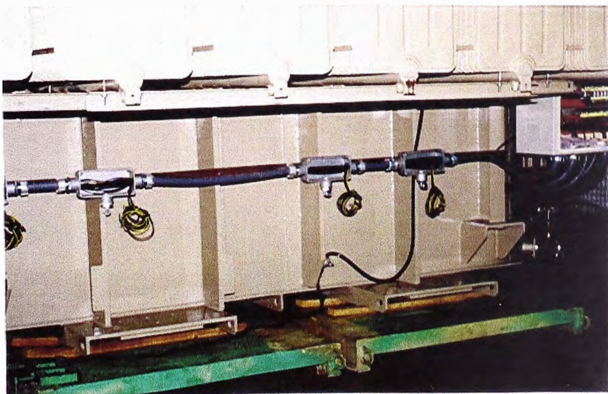
Cableado y cajas de pase de ventiladores (antes de colocar)
