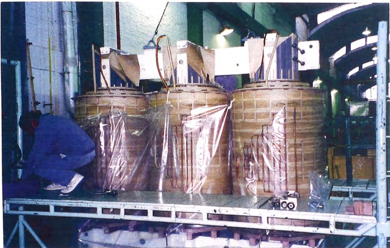
Montaje de Bobinas de Transformador.
