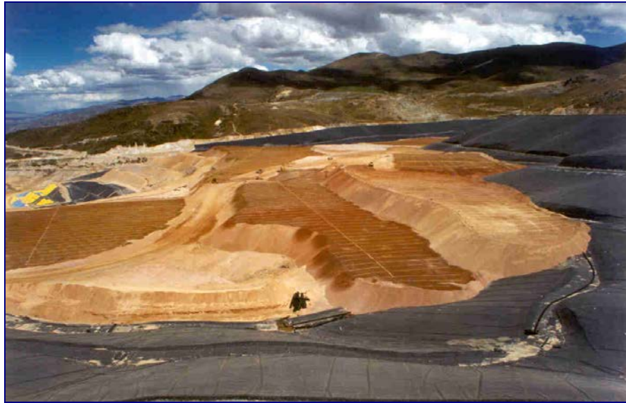
Figura N° 11: Pad de Lixiviación
