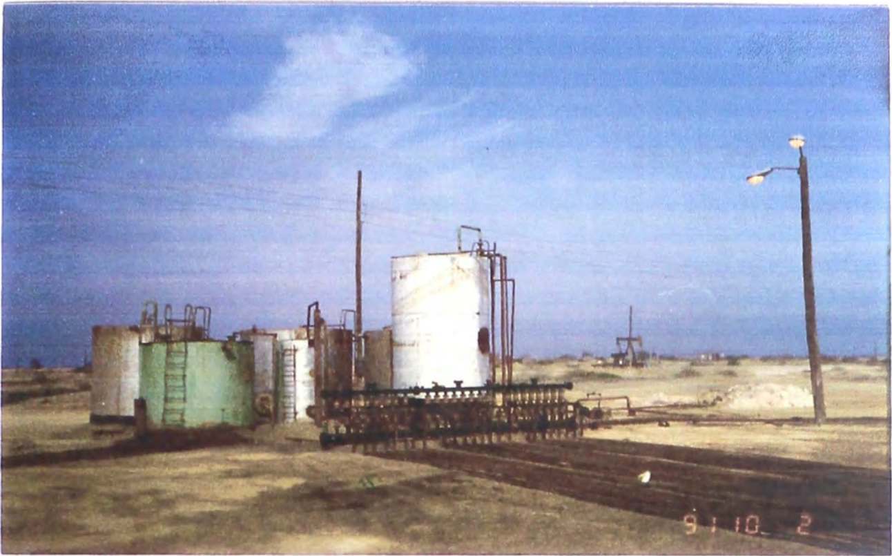
FOTO 4.1 BATERIA SATELITE CENTRAL 975-2 TALARA Las baterías de producción quedaron sobredimensionados y en los últimos años del proyecto se reemplazaron por baterías satélites, ya que a medida que se desarrolló el proyecto se hizo muchas modificaciones sustanciales en el proceso, una batería es un proceso dinámico, planeado y continuo; En la foto un manifold con 24 pozos, un gun-barrel de 150 barriles, un tanque de almacenamiento de 200 barriles, 4 tanques de prueba y una bomba de transferencia.
