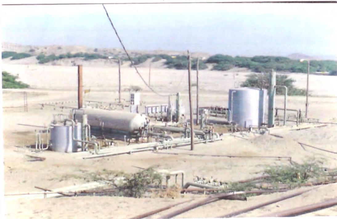
FOTO 5.2 Una de las funciones del Ingeniero de Facilidades es programar la limpieza y mantenimiento de Baterías, reparación de los ductos del sistema de producción y transporte de crudo, gas y agua en campos petrolíferos, en la foto se observa la Batería de Folche 893H en Talara.
