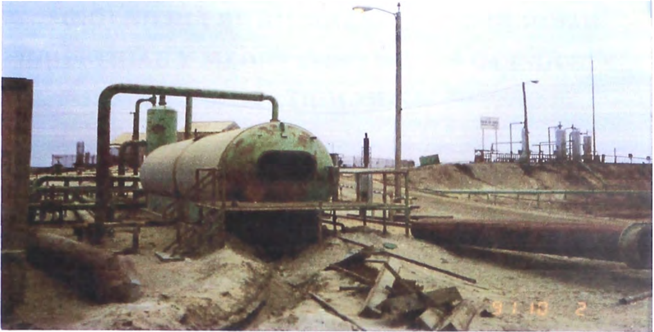
FOTO 9.1 ARENADO Y PINTADO DE RECIPIENTES. Los recipientes horizontales a presión (“vessels”) como separadores, tratadores térmicos, desaladores, depuradores de gas y los recipientes verticales que trabajan a baja presión (onzas) como los tanques de almacenamiento, tanques de lavado, están sujetos a corrosión, erosión o abrasión mecánica cuando entran en contacto con los agentes corrosivos y contaminantes, electrólitos del agua de formación del pozo; En la vista se observa un tratador en mantenimiento previamente la producción es recibido en otro tanque instalado en la izquierda.
