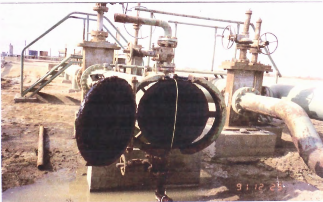
FOTO 3.2 PROGRAMAS DE LIMPIEZA EN DUCTOS; La finalidad básica de la limpieza en oleoductos y gasoductos con tapones de neoprene ( "pig"o chanco), llamado en la industria petrolera "Chanqueo de líneas" es mantener libre de sedimentos, parafina y sólidos la pared interna del ducto y remover las aguas estancadas en las catenarias; En foto se observa una trampa de recepción del "chancho" en la Bateria de Zapotal-951 en Talara.
