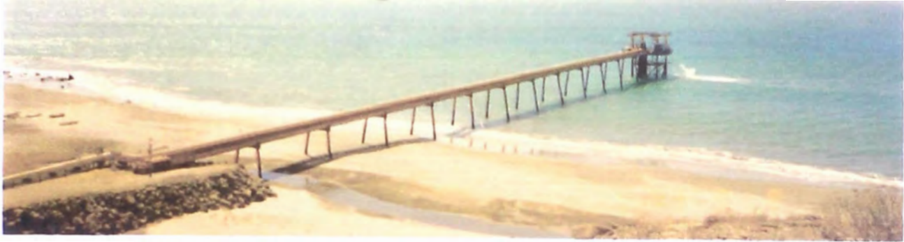
FOTO 8.1 MUELLE Y PLATAFORMA DE BOMBEO DE LA PLANTA DE TRATAMIENTO “OCEAN PLANT” Longitud 870 pies x 15.5 pies de ancho es el punto de captación del agua de mar, mediante las bombas de levantamiento de 150,000 barriles /día c/u con una presión de descarga de 120 psig, la tubería de descarga es de Fibra de vidrio(FRP) de 30 pulgadas de diámetro.
