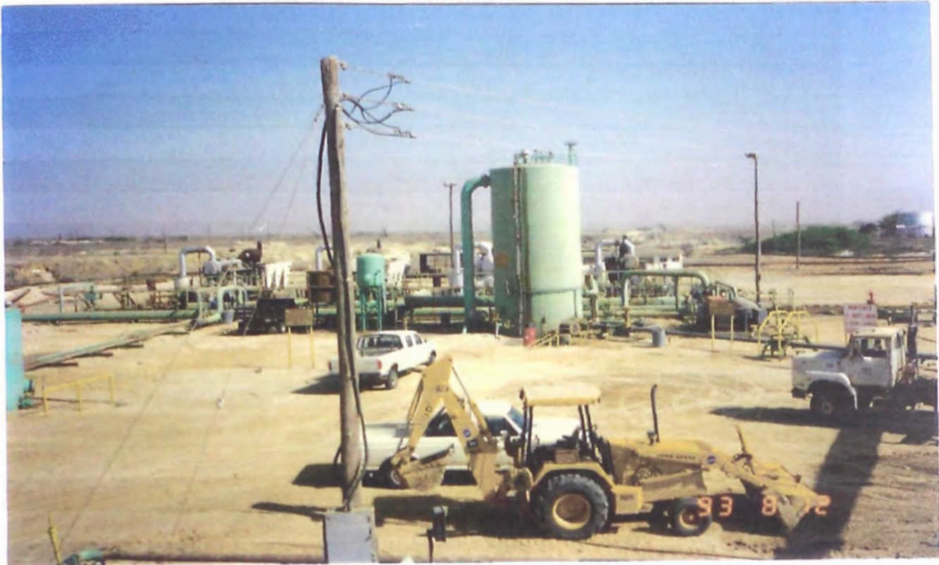
FOTO 8.3 PLANTA DE INYECCION DE CARRIZO-605 Al fondo se observa el Tanque de cebado de 1,000 barriles de capacidad y 4 Bombas de inyección marca Bingham 3x6x9 de 13 etapas con un desplazamiento de 27,000 barriles / día con motores marca MEP de 2,600 H.P a 900 r.p.m. c/u con una presión de descarga de 3,100 psig, a campo.
