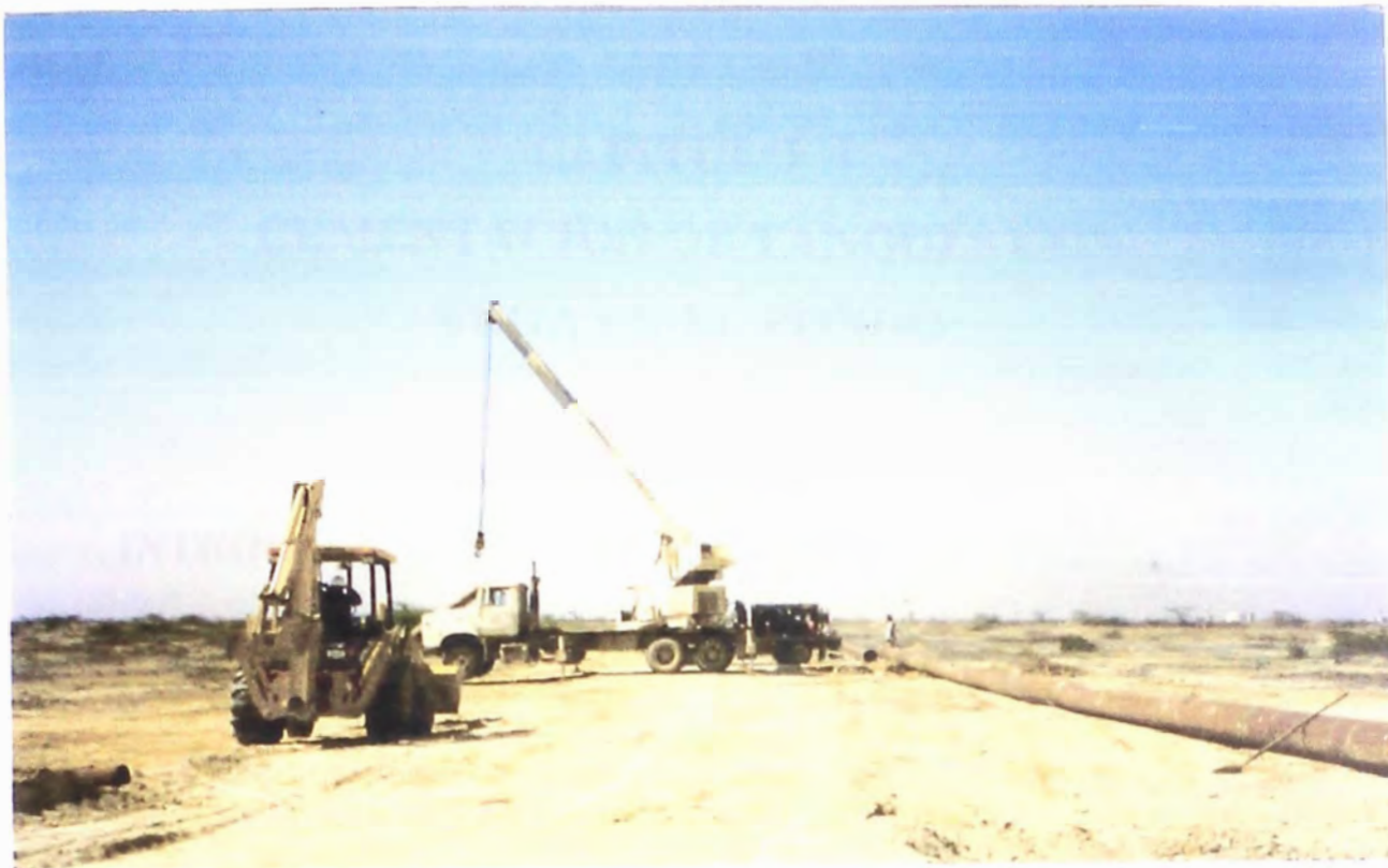
FOTO 3.1 PROGRAMAS DE MANTENIMIENTO DE DUCTOS; Los cambios de tramos en ductos que se encuentran en operación se hacen siempre con programas previamente planificados, coordinados, controlados y supervisados por el Ingeniero de Facilidades con todos los departamentos involucrados de la empresa, porque la logística del trabajo implica el uso de equipos costosos, en algunas casos se utiliza helicóptero para transportar los tubos(caso Selva) mientras que en la costa es más viable y económico; En la foto se observa tres equipos: una grúa, retro-excavadora y unidad de soldadura cambiando un tramo de 18" en Carrizo, Talara,
