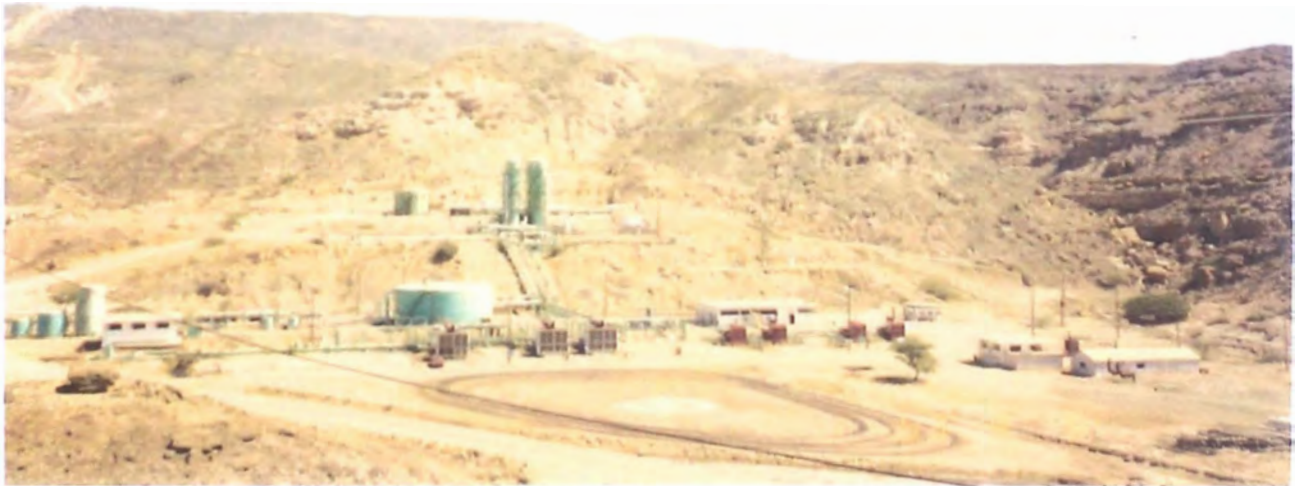
FOTO 8.2 PLANTA DE TRATAMIENTO “OCEAN PLANT” En el nivel superior se encuentra el área de los Filtros, las Torres de vacío, el Tanque de lavado de 3,500 barriles de capacidad, en el nivel inferior se encuentra el Tanque de cebado de 12,000 barriles, las Bombas de transferencia de 112,000 barriles /día c/u con una presión de descarga de 520 psig, la Planta de fuerza con 4 generadores(color rojo) y el cuarto de control al fondo.
