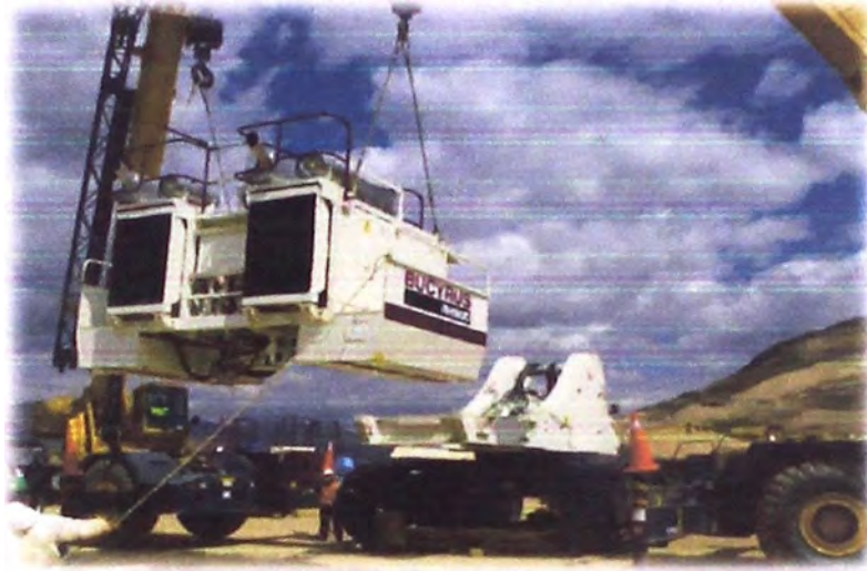
Fig. 4.7: Izando el Módulo Motor
