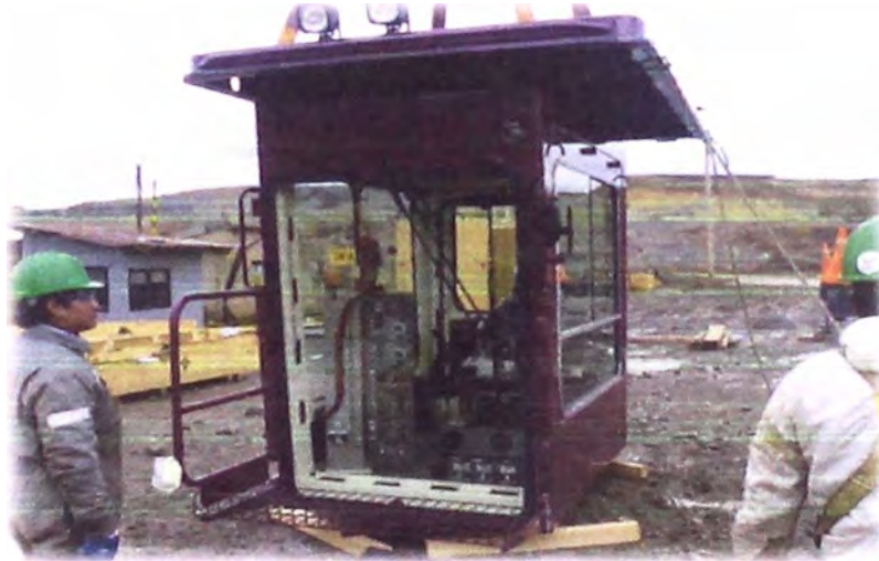
Fig. 2.34: Cabina del Operador listo para ser izado
