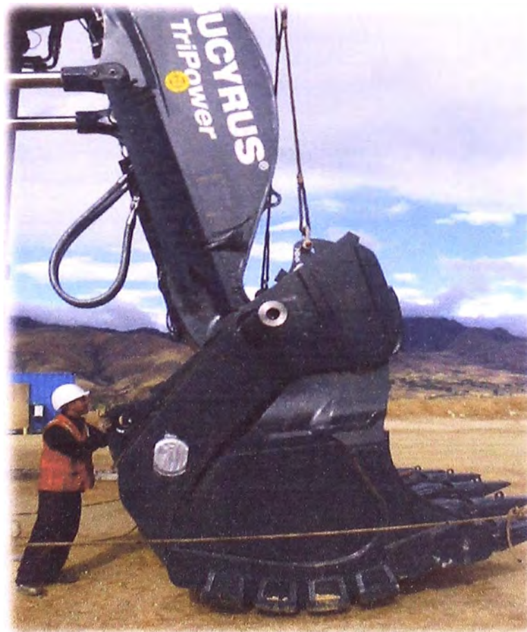
Fig. 4.17: Colocando el pin del Balde y Mango
