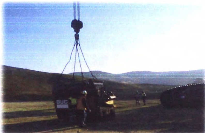
Fig. 4.10: A punto de elevar el Módulo Pede tal de Cabina
