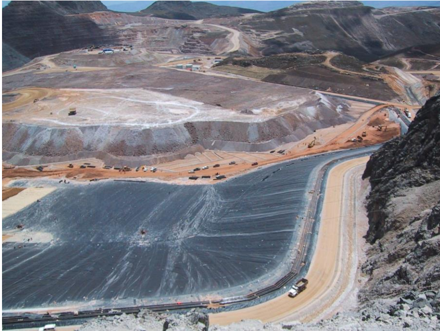
Figura 8.- Geomembrana Pad Carachugo Etapa 9
