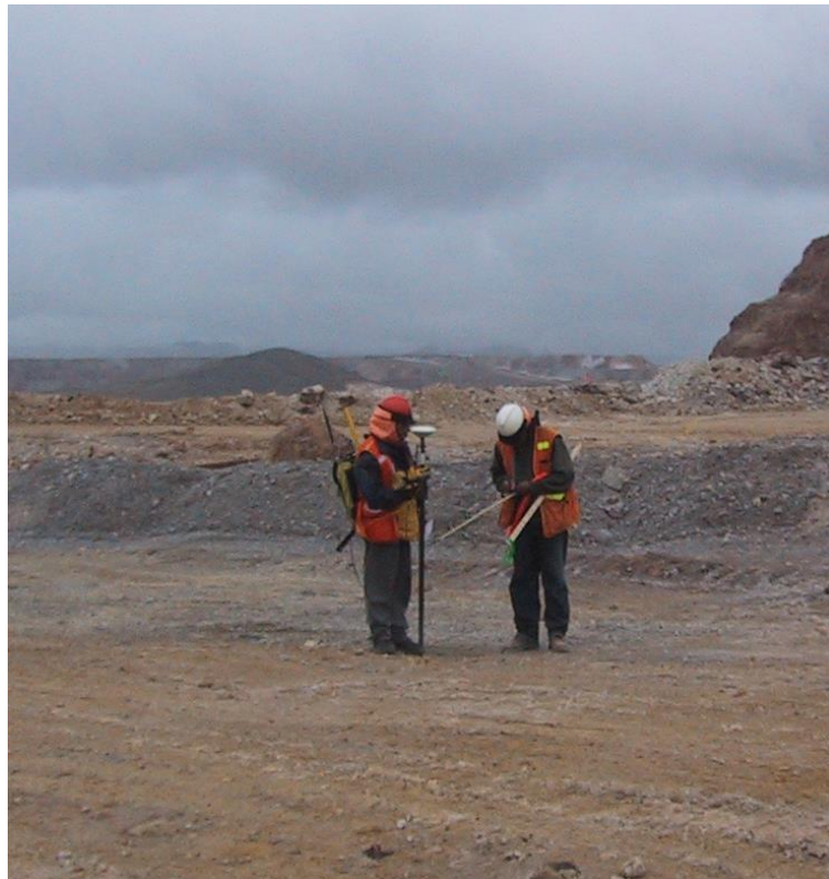
Figura 3.- Topógrafo y asistente de campo replanteando con GPS
