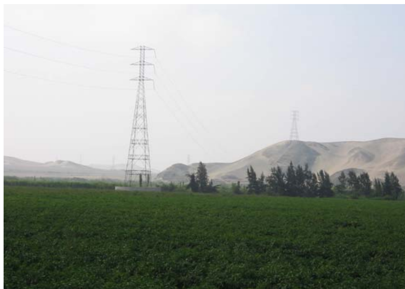
Foto 04: Línea interconectada nacional de alta tensión de 220 kv que va desde Lima hasta Tumbes, pasa a 75 km al Oeste de Invicta.
