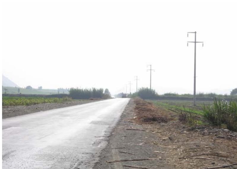
Foto 05: Línea de baja tensión de 22 kv que pasa por el pueblo de Sayán y provee de energía eléctrica al valle.
