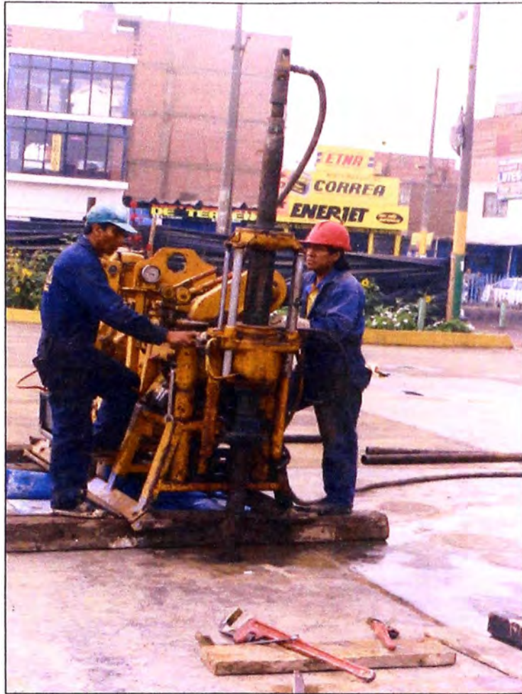
Equipo de perforación diamantina DIAMEC 750 de VALCAIN S.A. aplicando el método de perforación diamantina para evaluación de contaminantes en una estación de servicios fuera de operación
