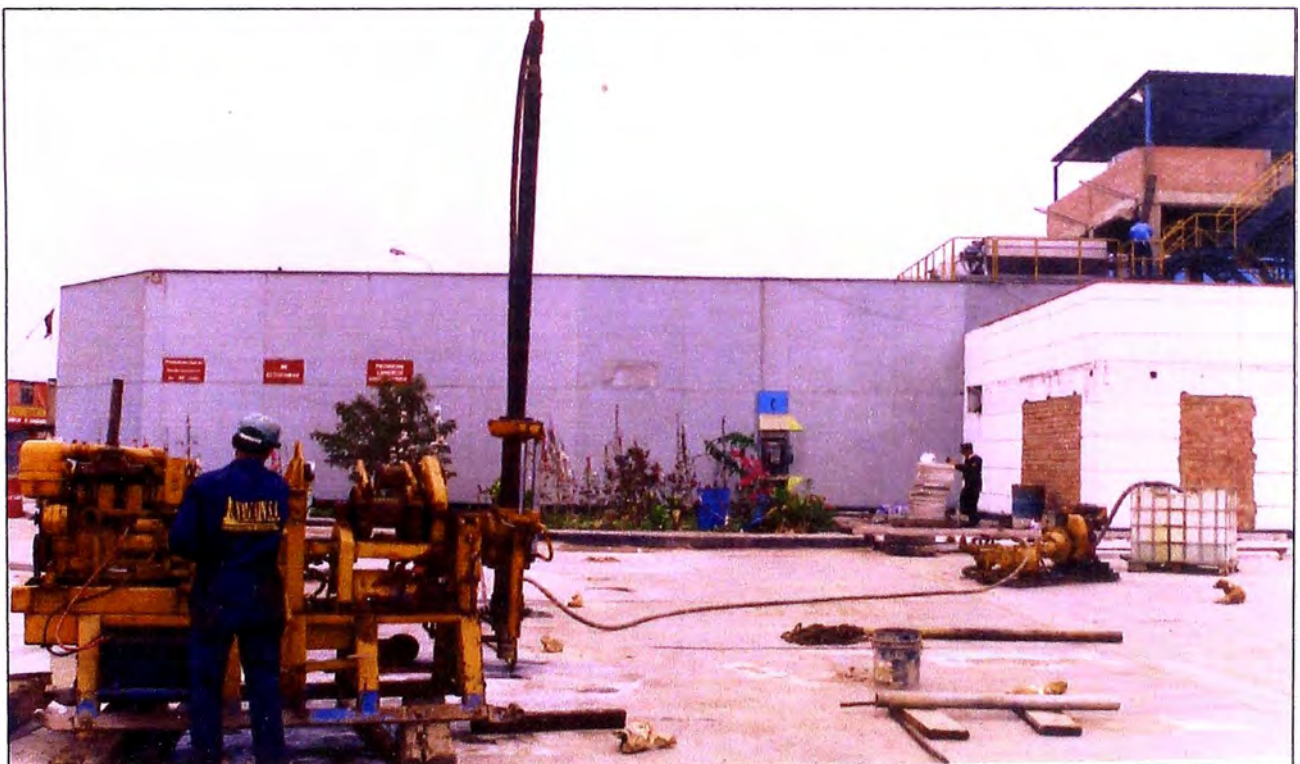
Equipo DIAMEC 750 perforando, para la perforación diamantina es necesario el uso de agua como lubricante y refrigerante para la perforación, detalle del abasto de agua, se emplean otras maniobras para lograra muestras inalteradas
