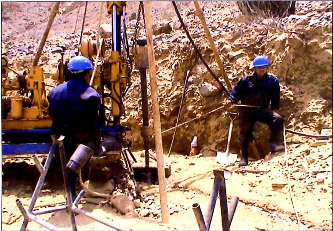
Ensayo de percusión en el campo
