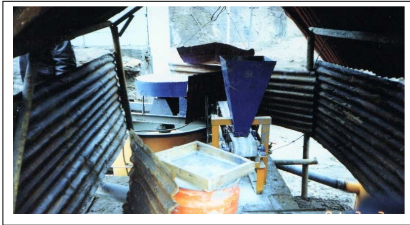
Foto 11 Planta Piloto – Neutralización Dinámica con relaves
