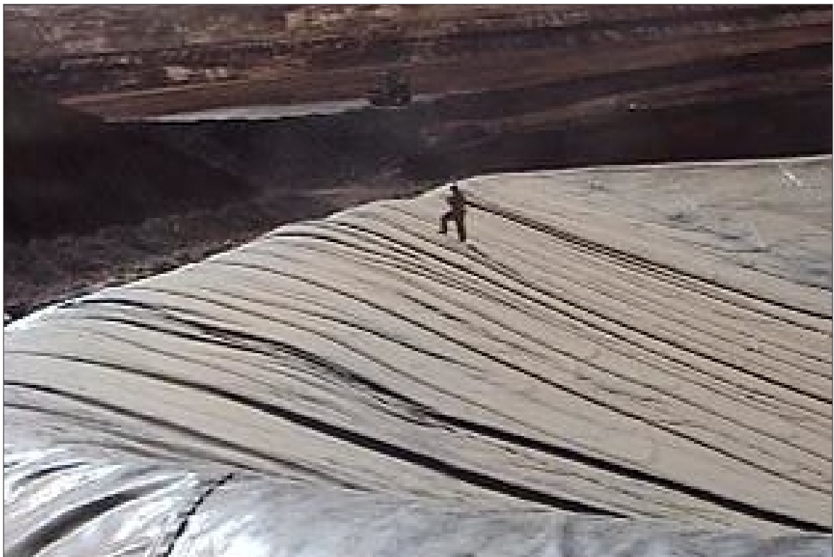
8.6 Anclado y pegado de Geotextil.
