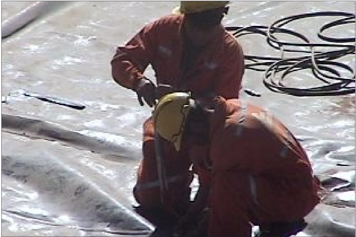
8.5 Instalación de Geomembrana.
