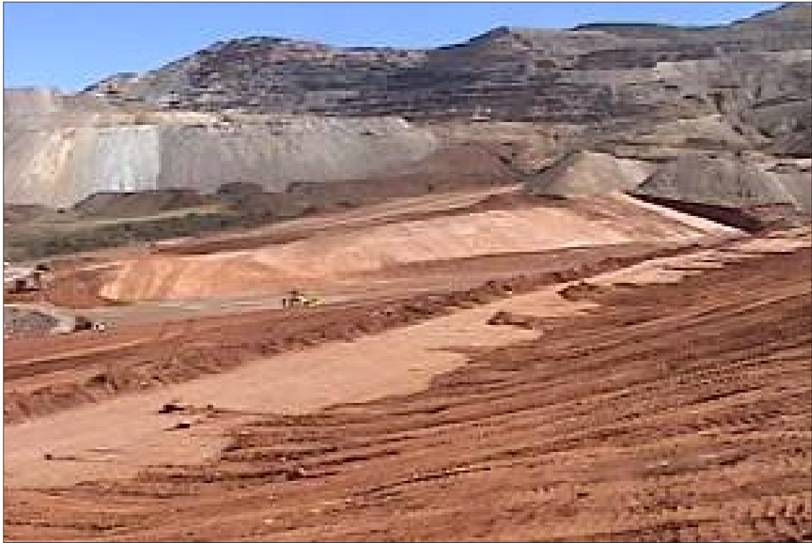
8.3 Corte de material y su retiro.
