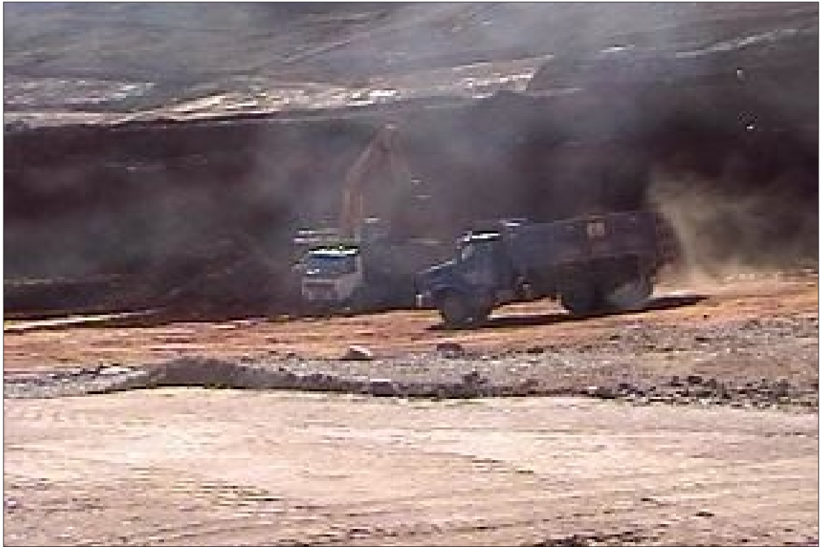
8.1 Excavación y evacuación del material de relleno.
