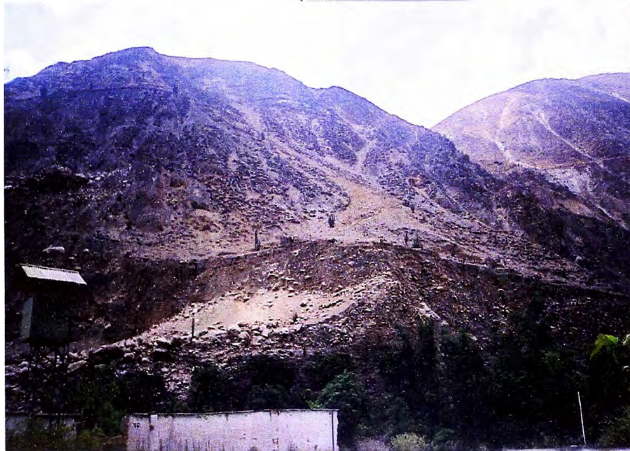
Foto N° 07.- Zona de ubicación del Vértice V-2B de la L.T. 22,9 kV (S.E. Quitaracsa – Toma) en depósitos aluvionales interdigitadas con depósitos caluviales, estimándose que dicho material supera los 6.0 m. de espesor.
