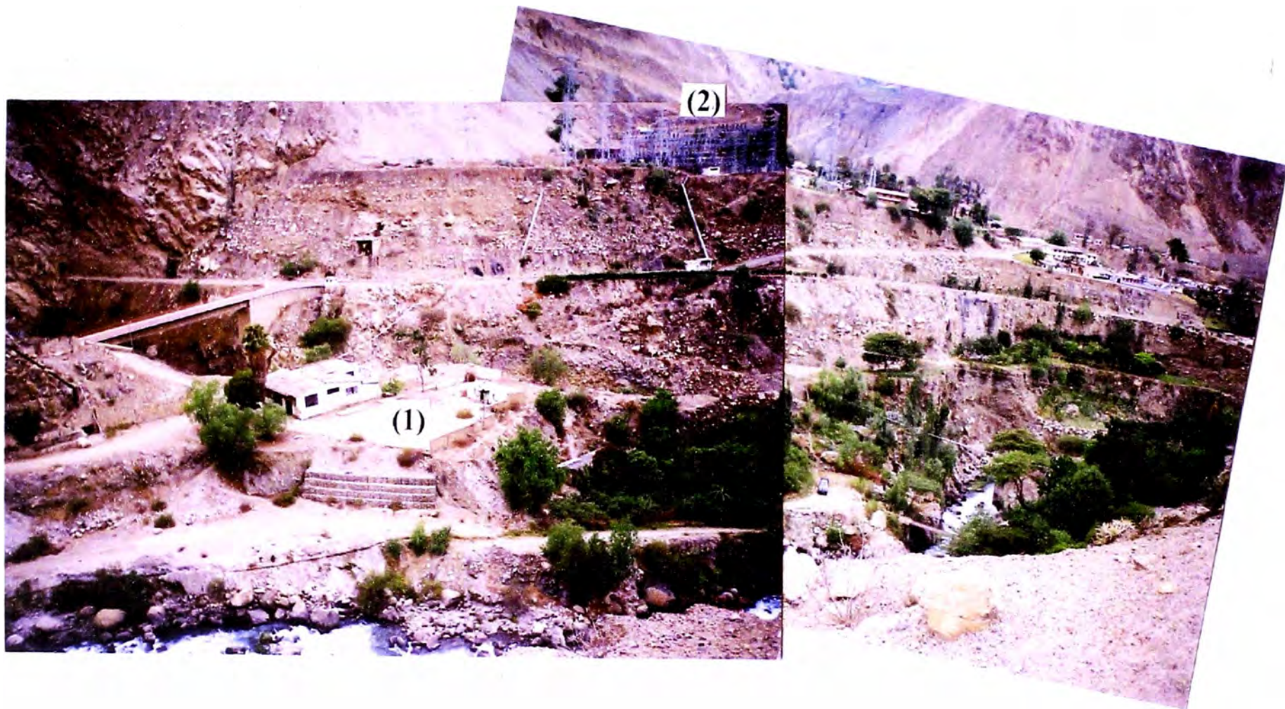
Foto N° 13.- Vista panorámica, tomada desde partes altas del flanco derecho del Río Quitarcasa, se puede observar la zona de ubicación de la S.E. Quitarcasa (1), y en la parte central superior la S.E. Huallanca (2).
