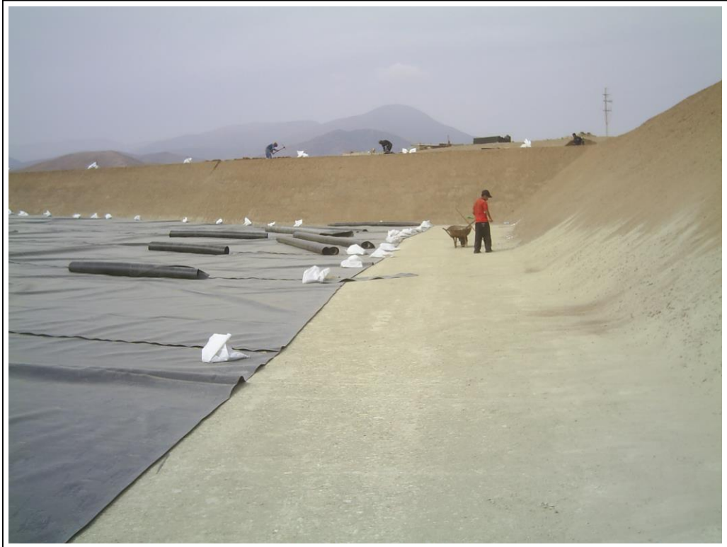
Foto 2.2-35. Relavera en plena puesta de geomenbrana.
