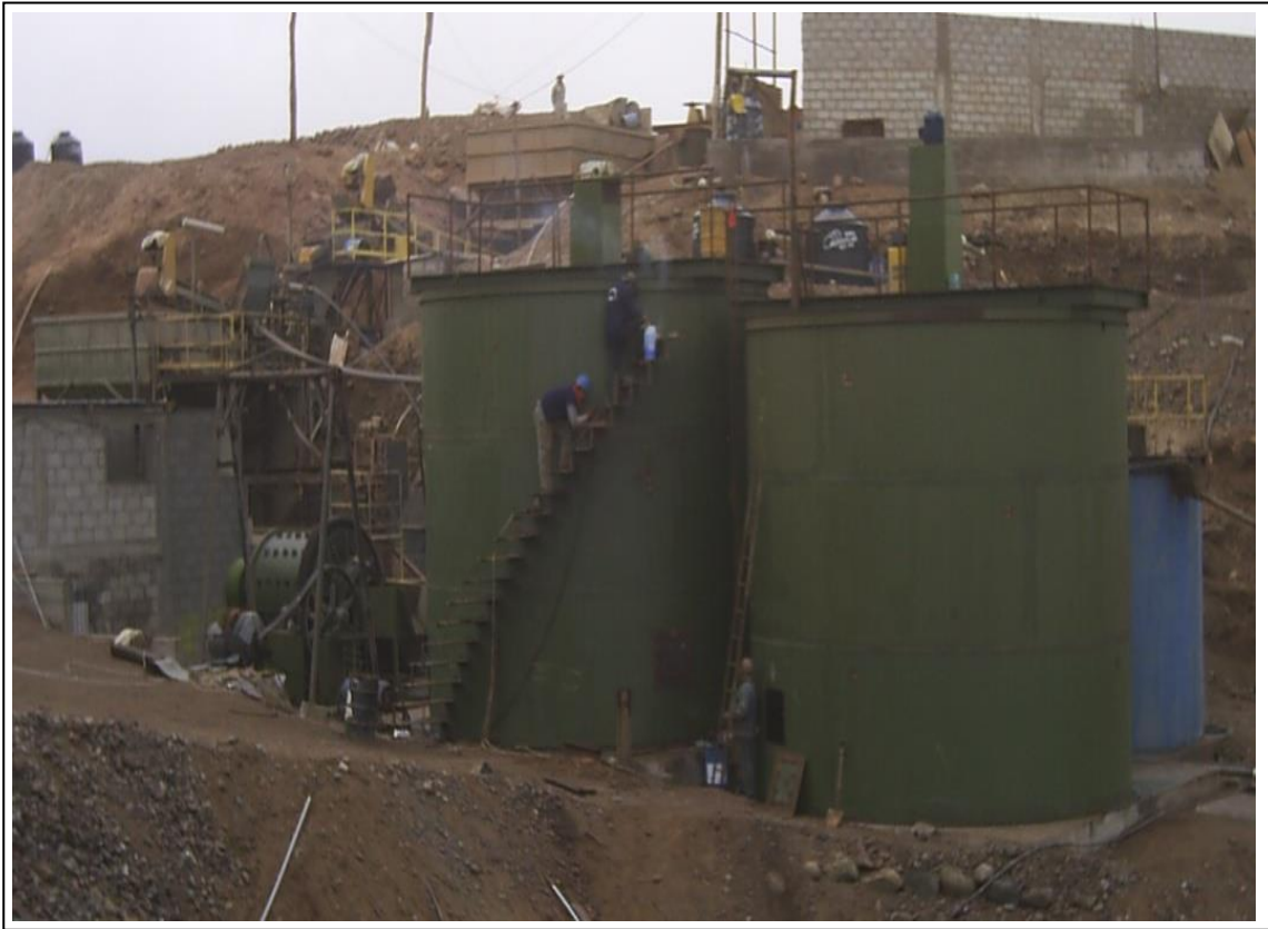
Foto 2.2-28. Tanques 18'x18' en plena construcción montaje de molino Denver 5'x5'. Se observa al hidrociclón y DSM al costado de la tolva de finos, se tenía una capacidad de proceso de 25 TMSD, con estos montajes se paso a 50 TMSD
