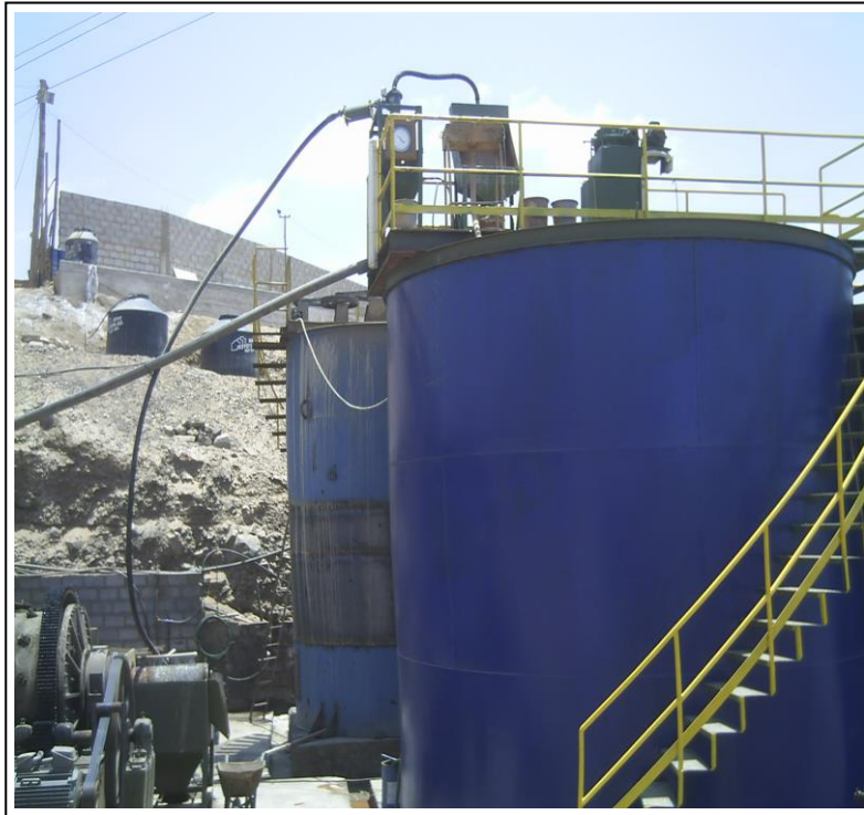
Foto 2.2-29. Tanques 12'x18' alargado y 18'x18' con el hidrociclón y DSM sobre el tanque, molino 5'x5' luego de ser montado.
