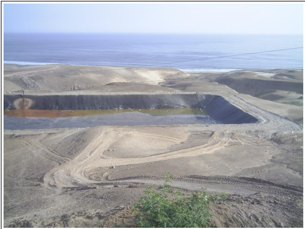
Foto 2.2-36. Disposición del relave, la solución barren se recircula al proceso
