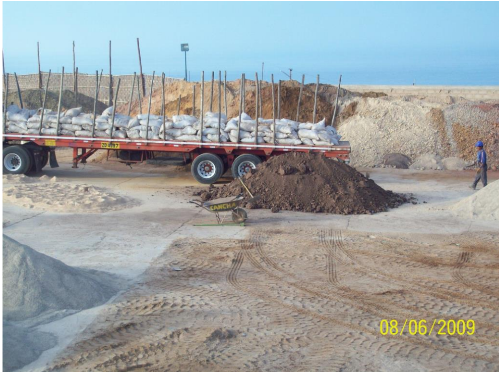
Foto 2.2-1. Cancha de Recepción de Mineral
