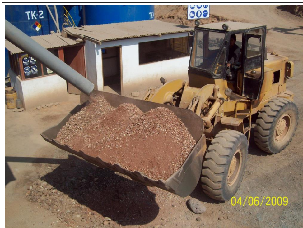
Foto 2.2-10. El producto chancado se recibe en el cargador frontal para su traslado a cancha de muestreo
