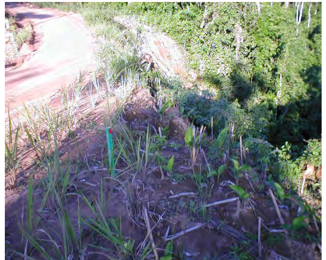
Fotografía N° 6: Paspalum virgatum recién sembrados en la línea de conducción – Proyecto Camisea Perú.
