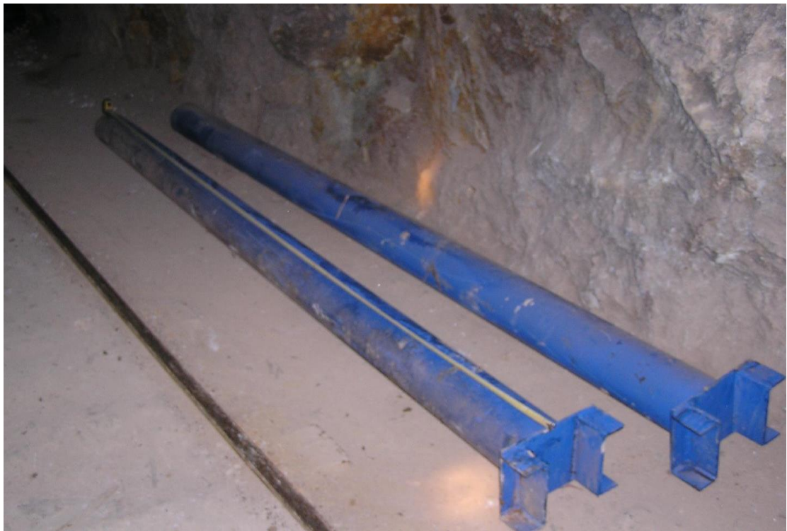
FOTO 1. En esta vista se observa 2 tubos metalicos de 6 pulgadas y de 3 m de longitud, lo cual van a ser instalados en el tajo 184 de la veta victoria al sur.
