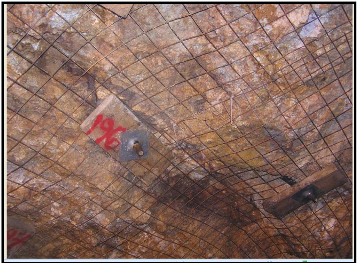
Figura 6. En esta grafica se observa la instalacion del perno swellex de 7 pies reforzado con malla electrosoldada en el tajo 1001 SW victoria.
