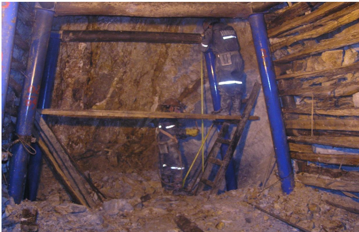
FOTO 2. En esta vista se observa como es la instalación de estos tubos metalicos como postes y de sombrero como puntal de 6 a 8 pulgadas. Se capacito al personal para realizar estos trabajos de instalación de tubos metalicos.
