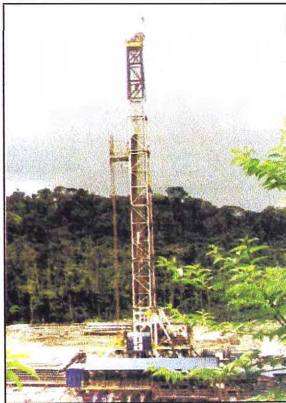
FOTO N° 1 EQUIPO DE PERFORACION
