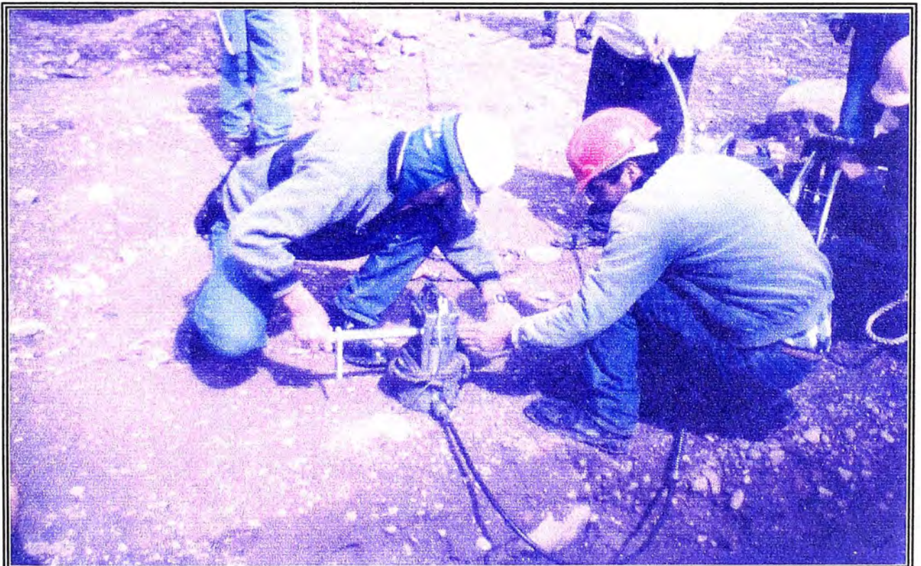
Foto N°. 04: Empalme del Termina de Anclaje. Para Torres N°. 45.
