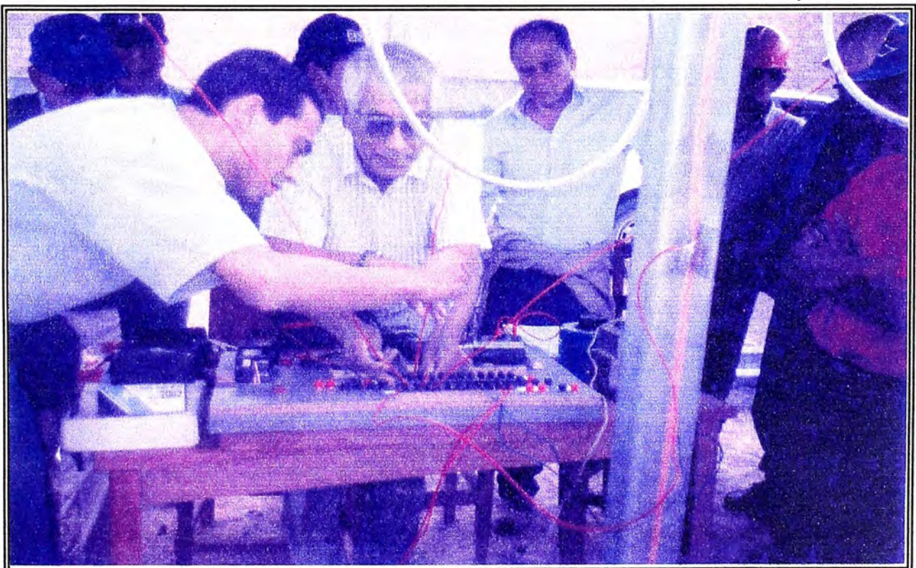
Foto N°. 08: Pruebas en Blanco de la L. T. 66 kV. Ayacucho - Cangallo.
