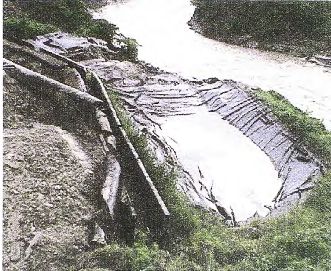
Crudo remanente en poza colapsada (14-05-1999)
