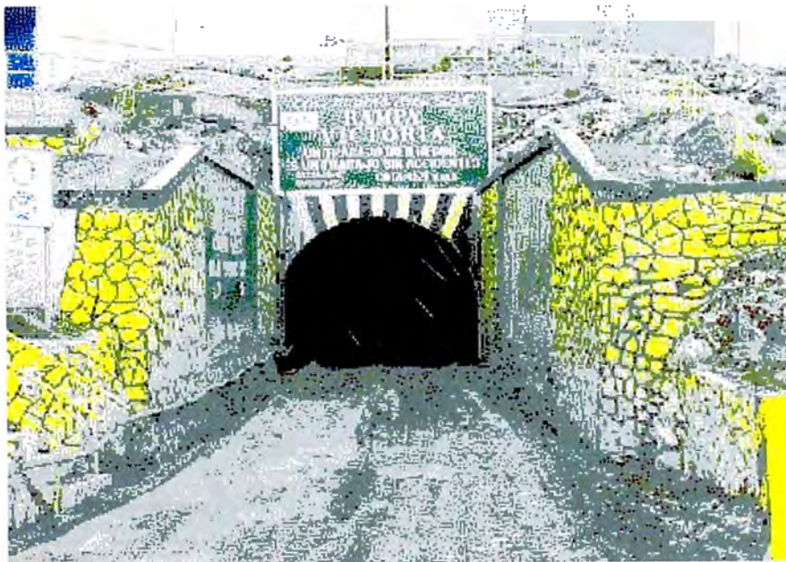
Foto: Entrada a la Rampa Victoria de Unidad Minera Ares.
