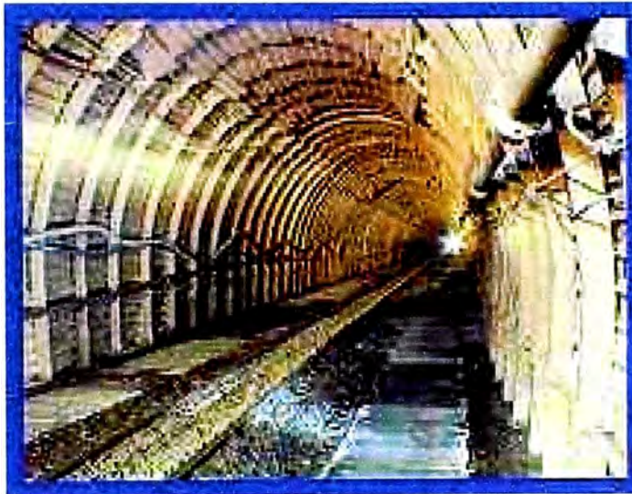
Figura 4.5.2 Túnel Linner Concluido
