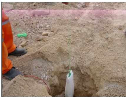
FOTO N° 09: Bajado al Taladro
