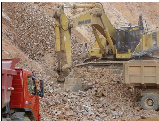
FOTO N° 22: Carguío de Volquete (3)
