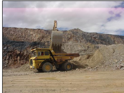
FOTO N° 16: Carguío de Material (2)
