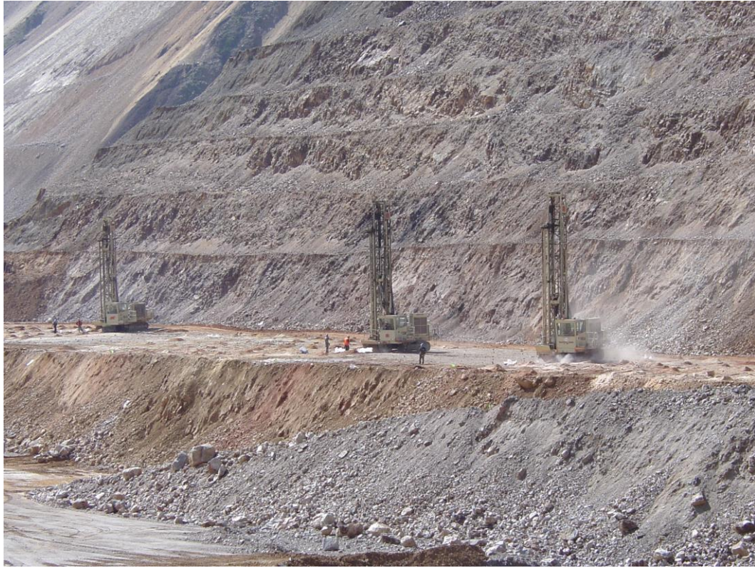
FOTO N° 01: PERFORADORAS DM-45 E (TAJO SEDUCTORA)
