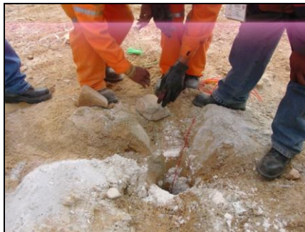
FOTO N° 11: Colocado de Piedra para sostener la bolsa
