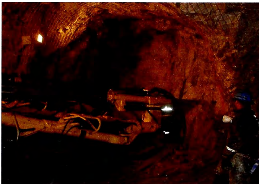
Figura 5. Perforación del frente.
