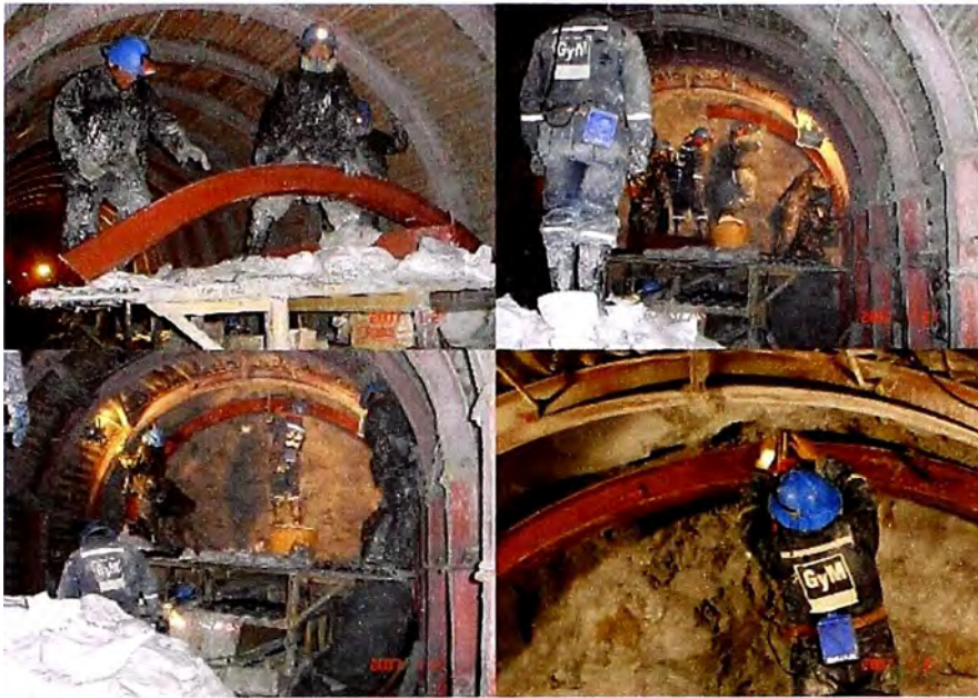
Figura 10. Sostenimiento con cimbra.
