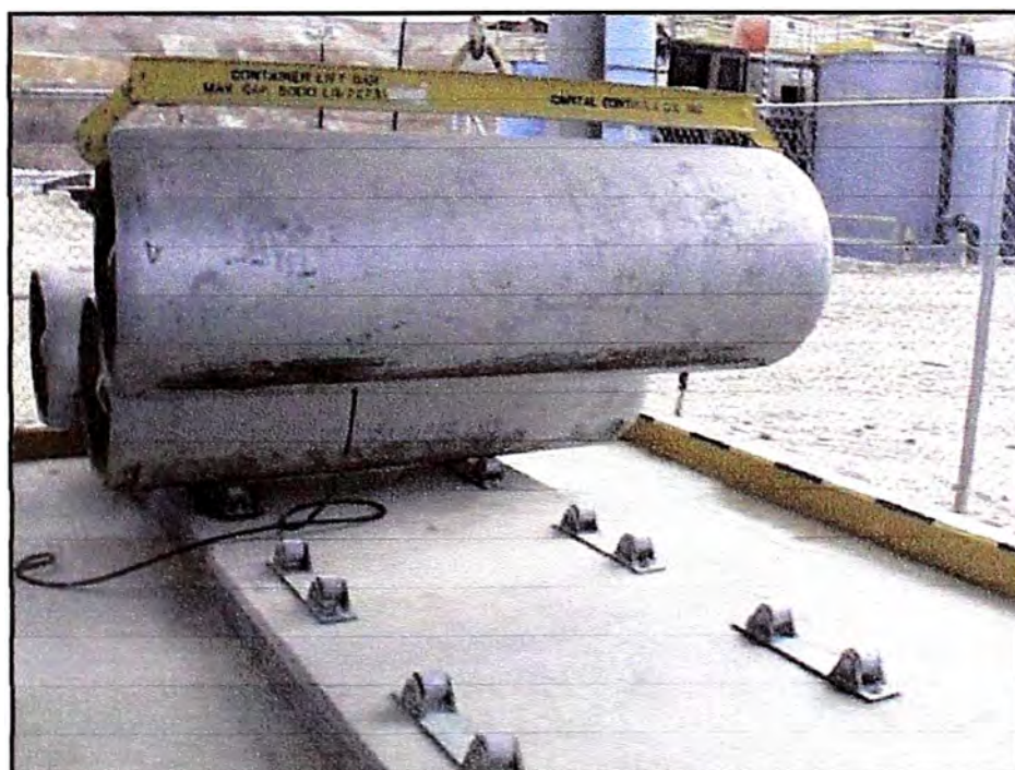
Figura 14. Tanques de Cloro
