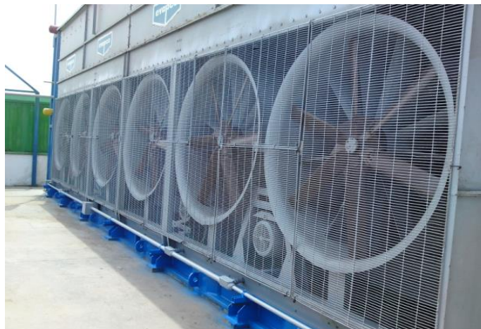
Fig.3.4.1 Condensador evaporativo
