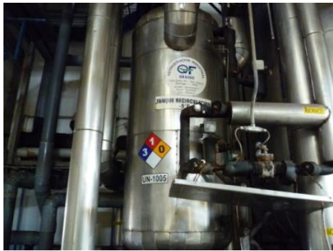
Fig.2.7.5.1.6 Tanque sistema -5°C
