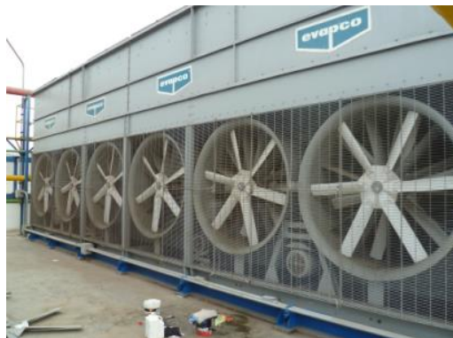
Fig.2.7.5.1.7 Condensadores evaporativos
