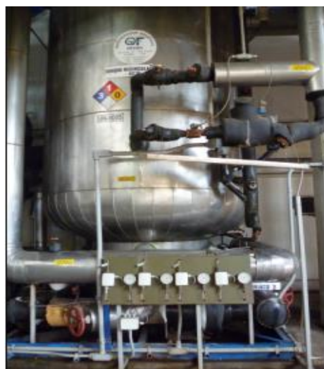
Fig.2.7.5.1.5 Tanque sistema -42°C
